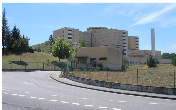
Fig.59: Entrada de serviço, a partir da N15, do Hospital Padre Américo.
