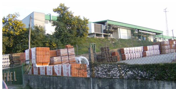
Fig.75: Entrada da Faprel desde a via de acesso da Zona Industrial 1.
