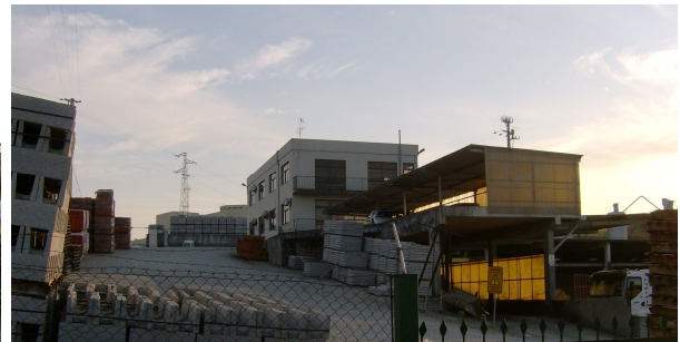
Fig.76: Entrada da Faprel desde a via de acesso da Zona Industrial 1.
