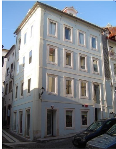
Figura 60 – Imóvel Municipal sito na Rua Quebra Costas n.º 1 a 3 depois da intervenção.
