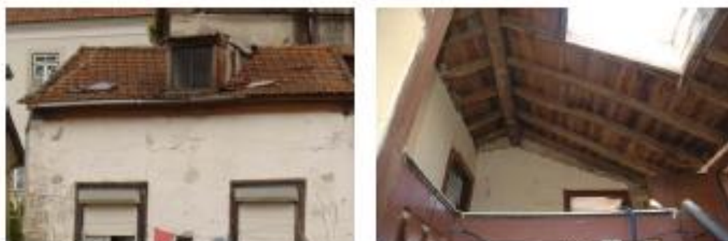
Visões da cobertura
