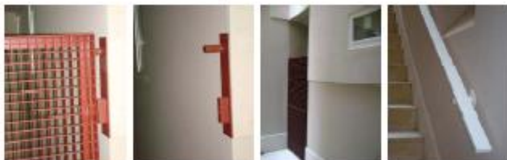
Gradil de acesso à garagem e corrimão da escada de acesso à Rua Joaquim A. De Aguiar
