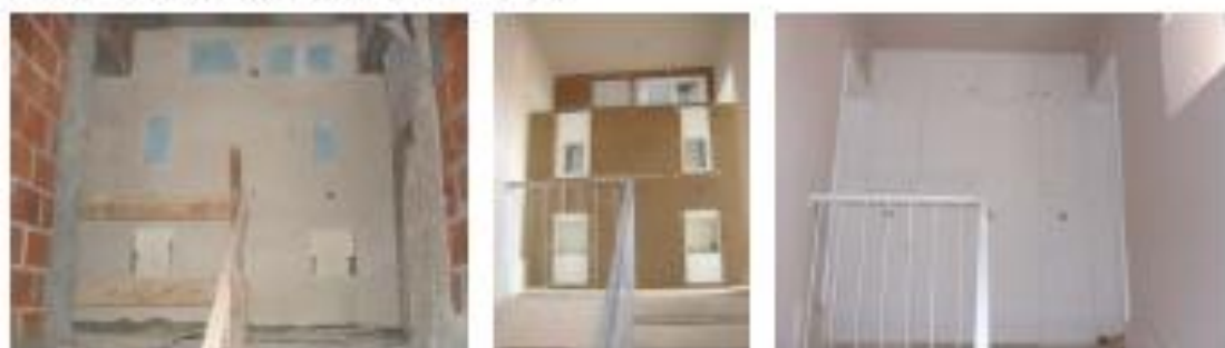
Topo das escadas comuns durante e no final da obra
