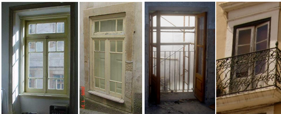
Figura 48 – Exemplos de caixilhos originais, pintados. Vista interior e exterior.
