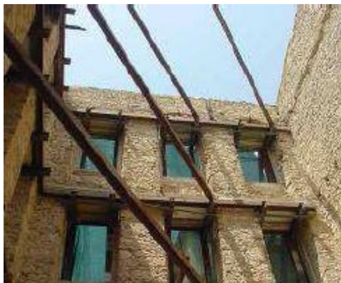
Figura 63 – Exemplo de contenção de fachadas.
