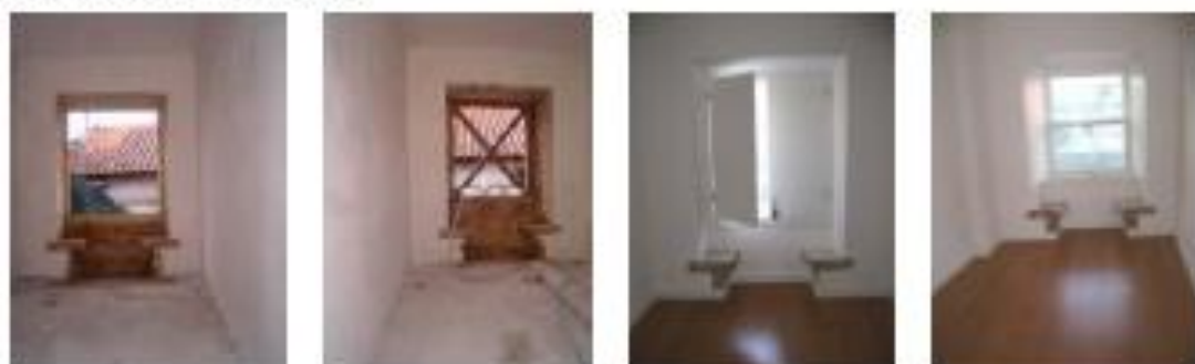
"Conversadeiras" existentes durante e depois da intervenção
