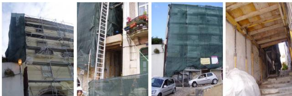
Figura 31 - Montagem de andaimes e de rede de protecção.
