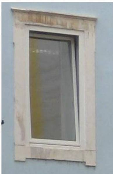
Figura 68 – Exemplo de caixilho basculante de folha única.
