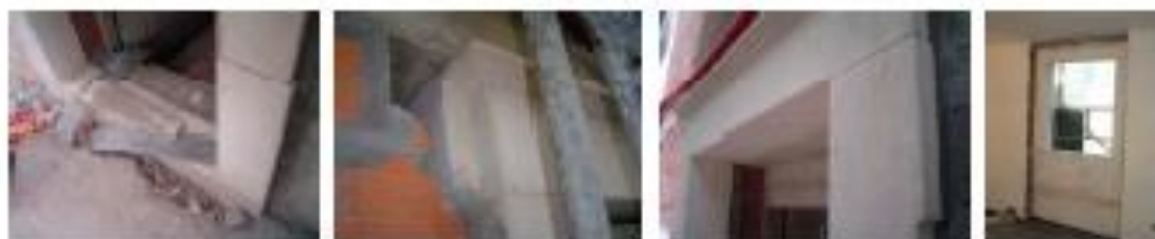
Cantarias em pedra maciça em fase de aplicação
