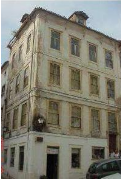
Figura 59 – Imóvel Municipal sito na Rua Quebra Costas n.º 1 a 3 antes da intervenção.
