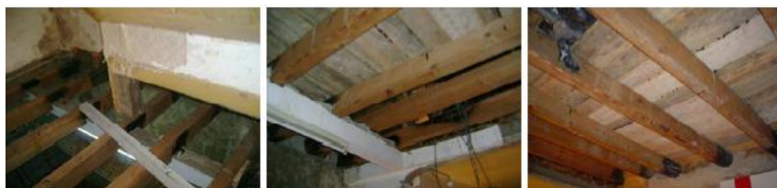
Figura 38 – Execução do pavimento em régulas de soalho e do vigeamento de suporte no Imóvel sito na Rua Couraça Dos Apóstolos nº62.
