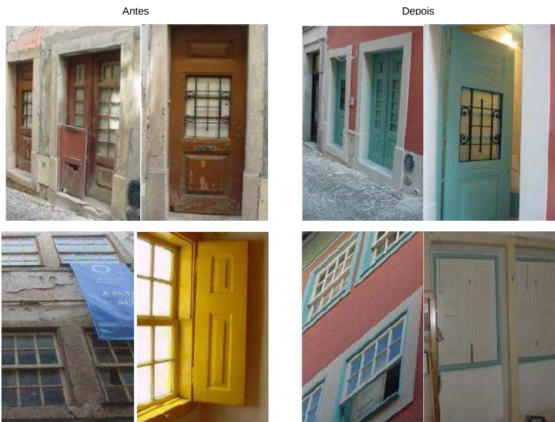
Figura 49 - Exemplos de reabilitação de caixilhos exteriores no Imóvel sito na Rua Fernandes Tomás nº 31 a 33.
