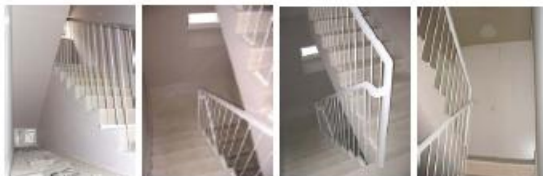
Arranque das escadas comuns durante e no final da obra
