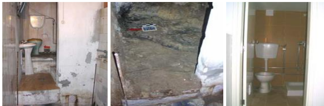
Figura 35 – Intervenção no wc do Imóvel sito na Rua Joaquim António de Aguiar nº 26 a 28 e Escadas de S. Cristóvão nº2 a 4.
