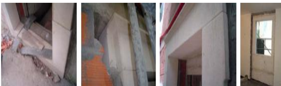
Figura 84 - Cantarias em pedra maciça em fase de aplicação.
