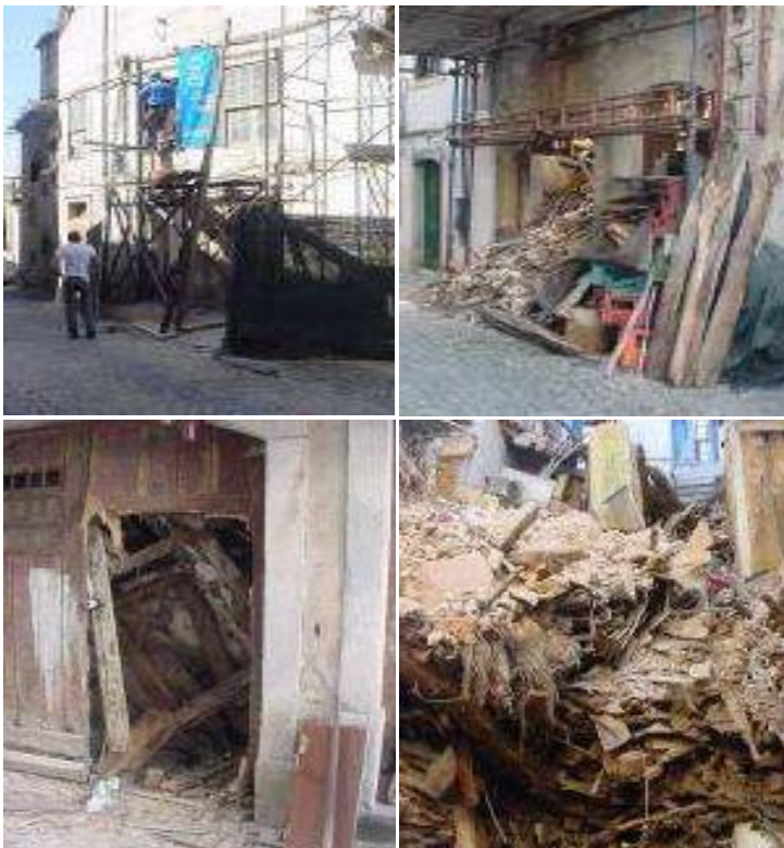
Figura 73 - Obras de contenção de fachadas e remoção de entulhos.
