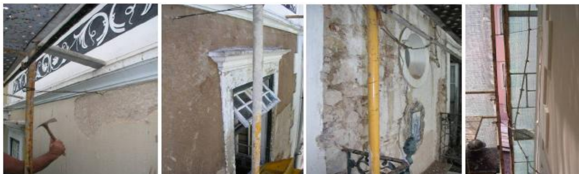
Figura 40 - Trabalho de recuperação de fachada no Imóvel sito na Travessa da Trindade nº 1
