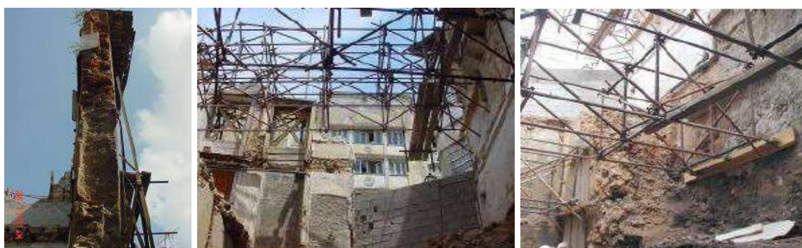
Figura 75 - Contenção e remoção dos escombros. Instalação de uma estrutura metálica, vigas caixão, para a sustentação das empenas das construções.
