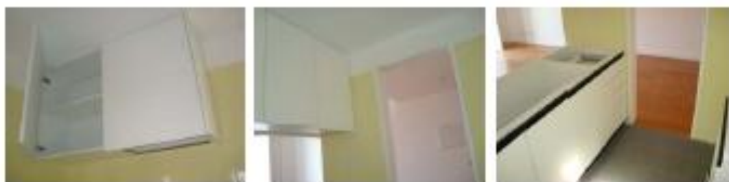
Piso 4 cozinha do T1 durante a intervenção
