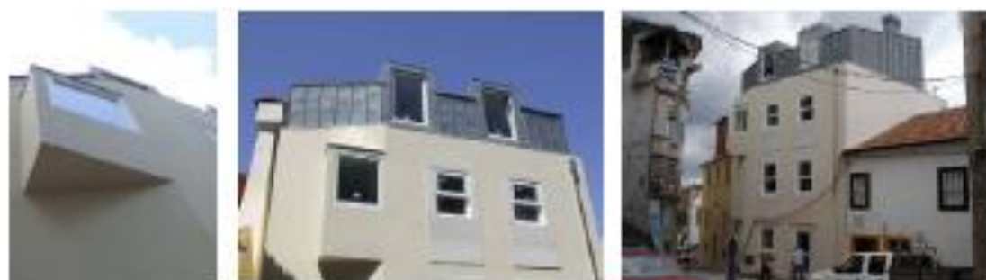
Fachada Nascente após intervenção
