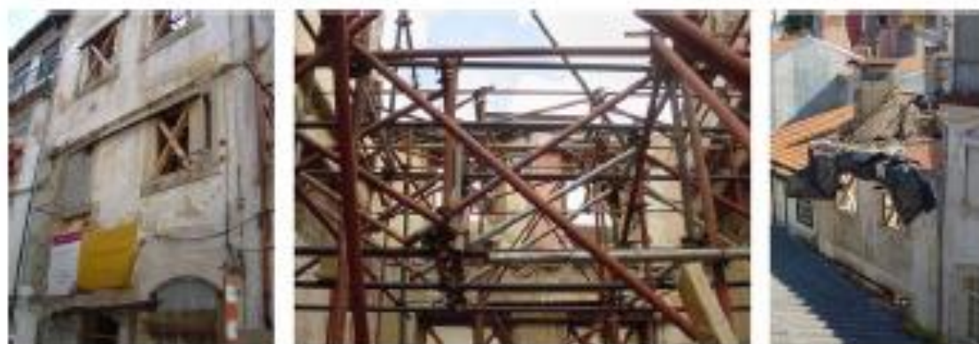
Estrutura metálica para contenção de empenas antes da intervenção
