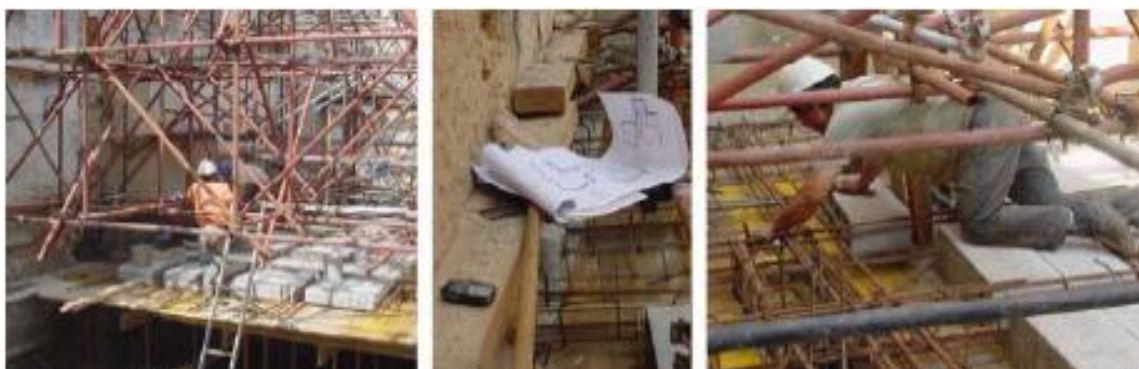
Figura 76 - Estrutura de contenção que ia sendo retirada à medida que se faziam os pisos.
