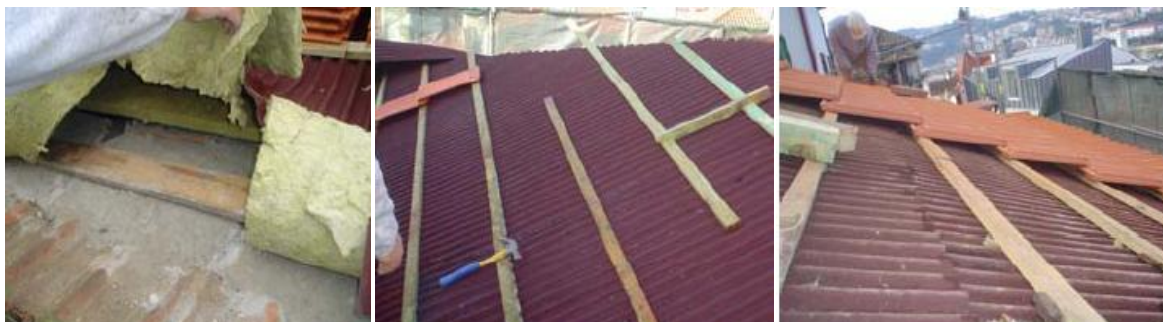
Figura 46 – Isolamento térmico aplicado sob uma estrutura de suporte e colocação de sub-telha, na qual foi assente telha Marselha, Intervenção no Imóvel sito na Rua Joaquim António de Aguiar, n.º 30 a 40.
