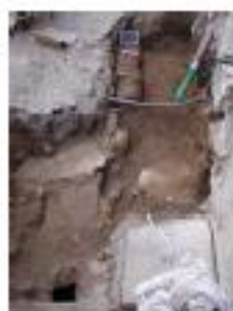
conduta exterior antiga
