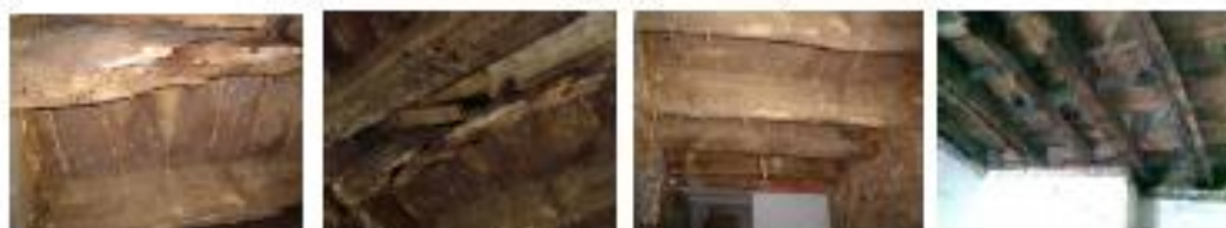
Estado das estruturas em madeira
