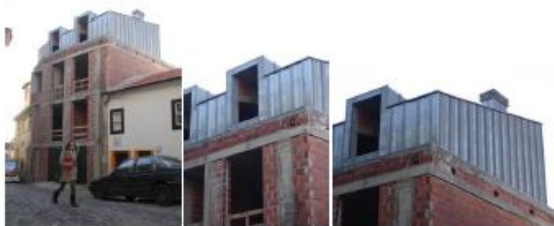
Fachada Nascente durante a intervenção
