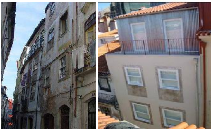
Figura 72 – Imóvel sito na Rua Joaquim António de Aguiar nº9 a 13 – antes e depois da intervenção.
