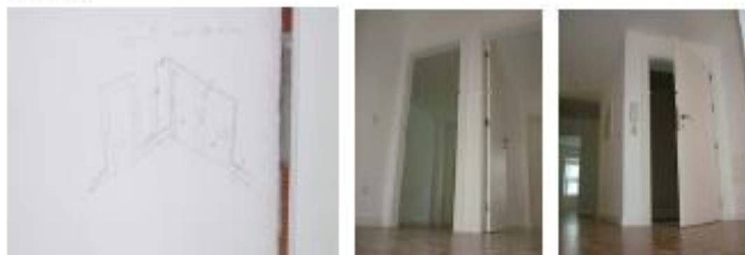
Esquízo e colocação das guarnições das portas
