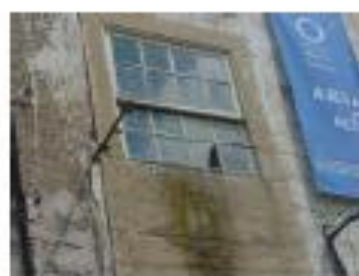
Estado da caixilharia e vidros
