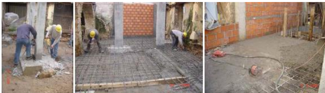
Figura 64 – Execução do ensoleiramento geral.
