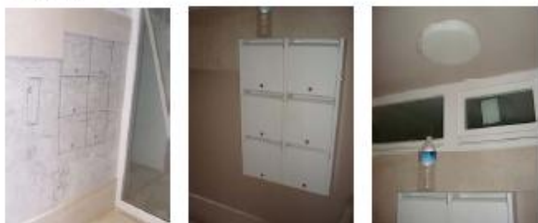
Esquízo e colocação das caixas de correio no saguão de entrada
