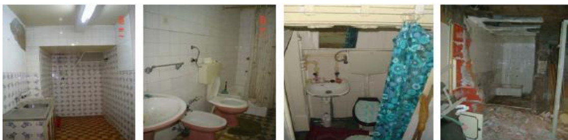
Figura 36 – Antes da intervenção nos wc e cozinha do Imóvel sito na Rua Couraça Dos Apóstolos nº 62.
