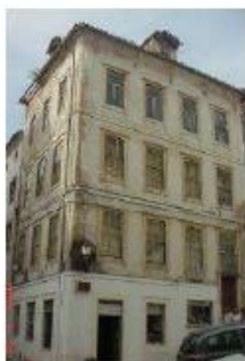
Antes da intervenção
