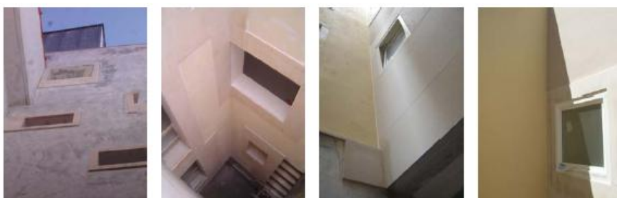
Figura 81 - Saguão de entrada durante e no final da obra.
