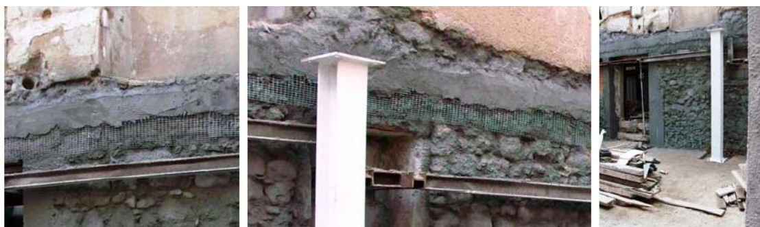
Figura 66 – Aplicação da armadura em malha metálica para consolidação das paredes existentes.
