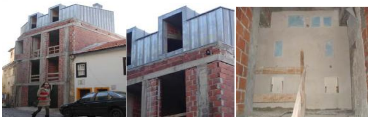
Figura 79 – Imóvel em construção.
