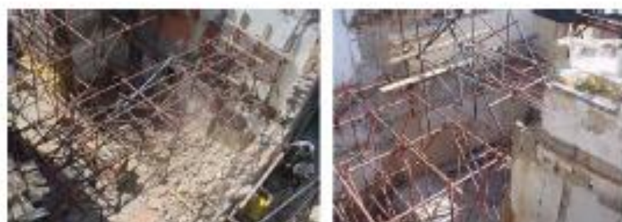
Demolição do que restou da derrocada de 25 de Maio de 2004
