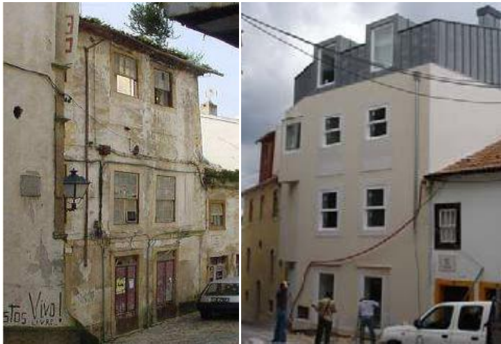
Figura 71 – Imóvel sito na Rua Fernandes Tomás nº 83 a 85 – antes e depois da intervenção.
