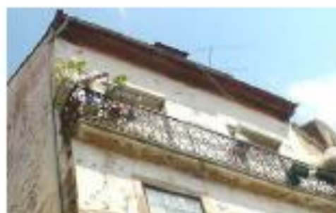
Caleiras e tubos de queda
