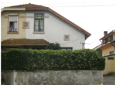
CASA 17 - VÃO SUPERIOR ORIGINAL COM SISTEMA DE SOMBREAMENTO INTERIOR
