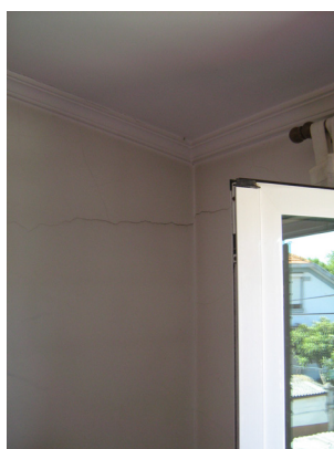
CASA 15 - PAREDE DO QUARTO, ACRESCENTO, PISO 1
