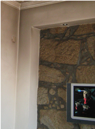
CASA 15 - PAREDE DE MEACÃO, PEDRA À VISTA
