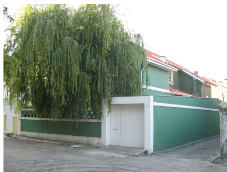
CASA 47 - ALTERAÇÃO DA SUA ALTURA E RECONSTRUÇÃO DO TIJOLO DECORATIVO
