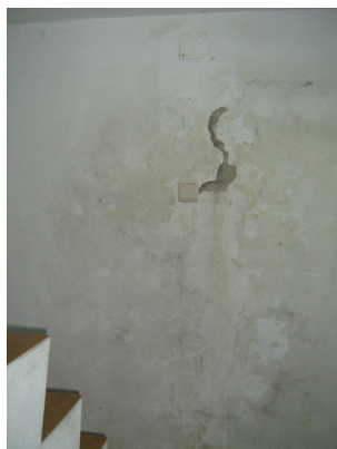
CASA 15 - PAREDE DA CAVE
