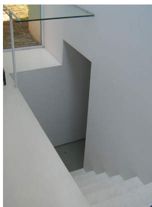
CASA 47 - ÚNICO ACESSO À CAVE, INTERIOR
