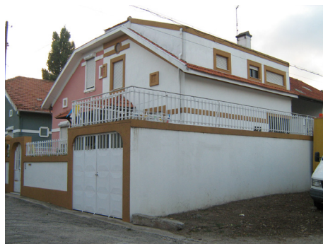
CASA 7 - INTRODUÇÃO DE ACRESCENTO SOBRE A COBERTURA E LATERALMENTE
