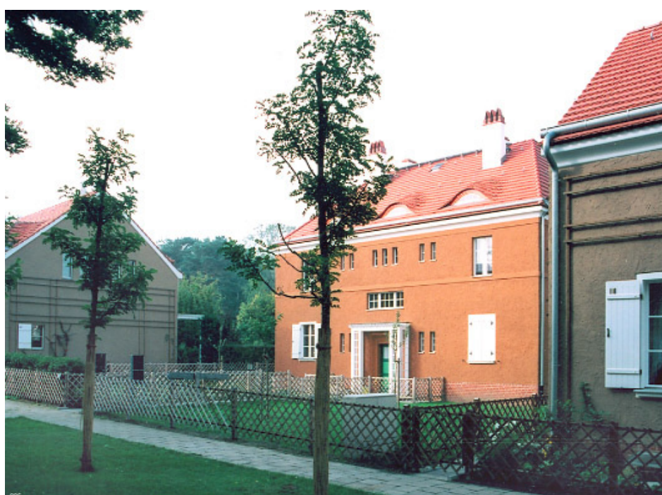
132. GARTENSTADT FALKENBERG – – TUSCHKASTENSIEDLUNG
