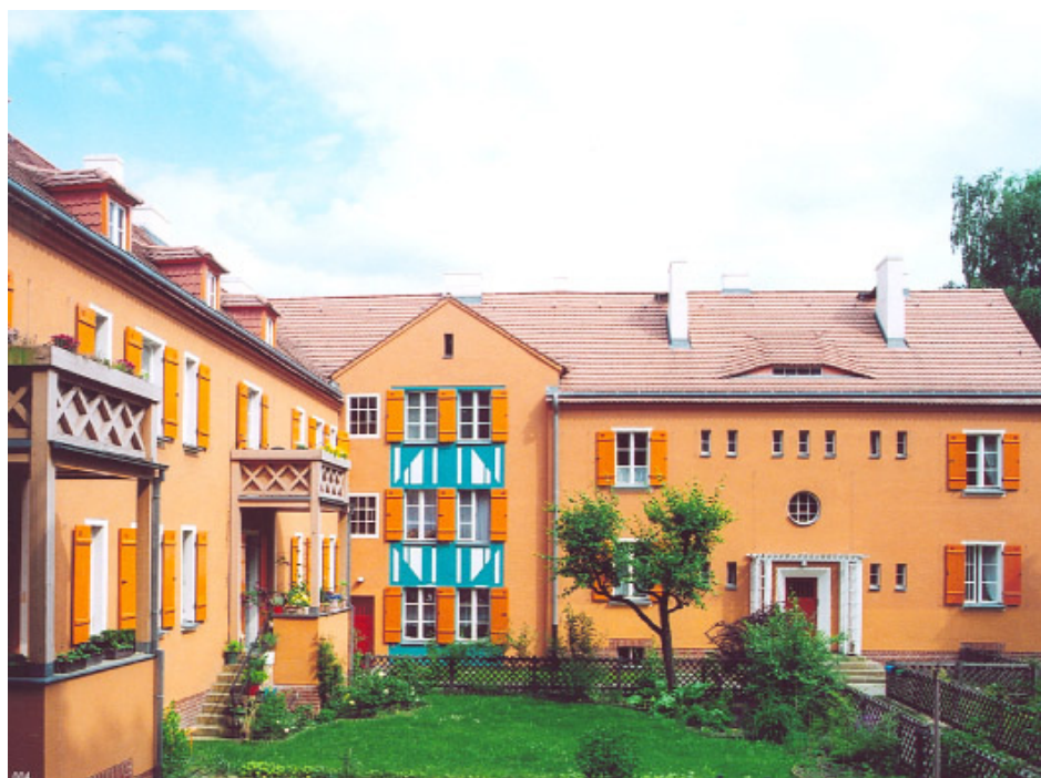
131. GARTENSTADT FALKENBERG – – TUSCHKASTENSIEDLUNG
