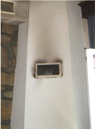
CASA 15 - RECUPERADOR DE CALOR NA SALA
