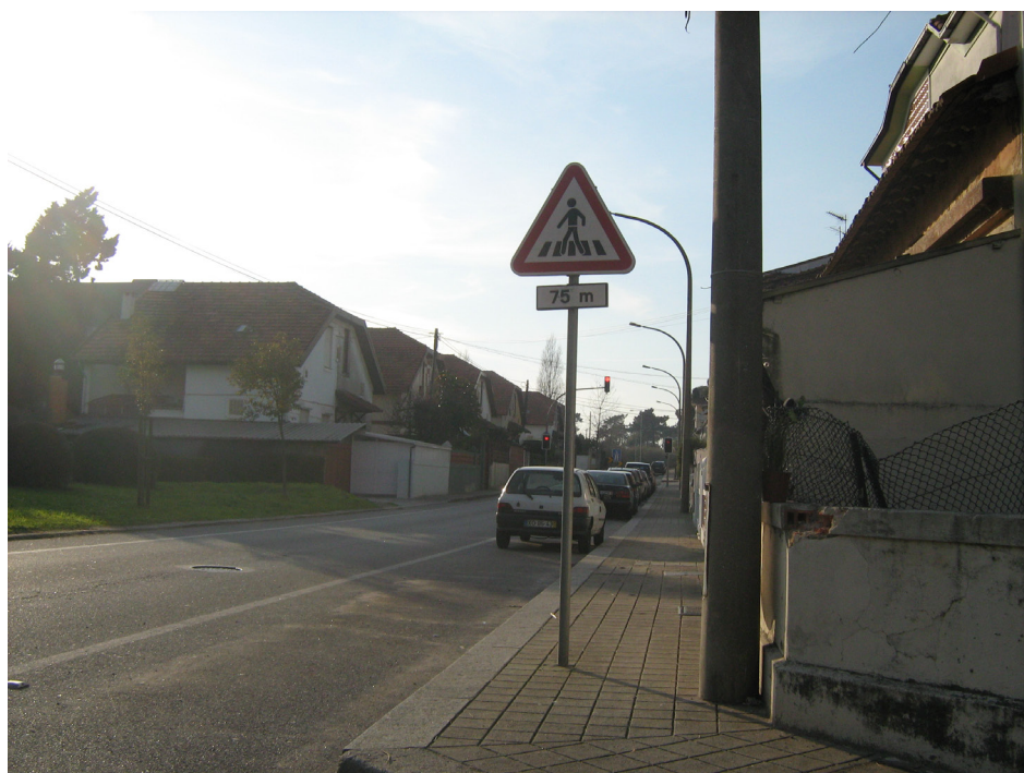
70. VIA DE ACESSO À VCI INDICAÇÃO DA PASSADEIRA
