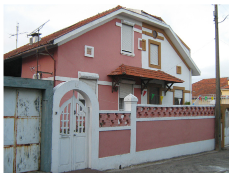
CASA 8 - ALTERAÇÃO DA SUA ALTURA E RECONSTRUÇÃO DO TIJOLO DECORATIVO
