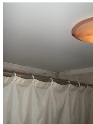
CASA 43 - TECTO DO WC, PISO 0
