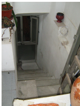
CASA 41 - ACESSO À CAVE PELO INTERIOR
