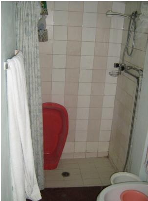
CASA 44 - WC - ABASTECIMENTO DE ÁGUA
