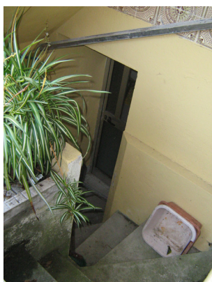
CASA 41 - ACESSO À CAVE PELO EXTERIOR
