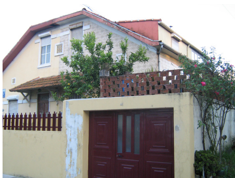
CASA 41 - ALTERAÇÃO COMPLETA DO MURO
