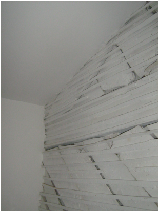
CASA 47 - PAREDE DIVISÓRIA, TABIQUE À VISTA
