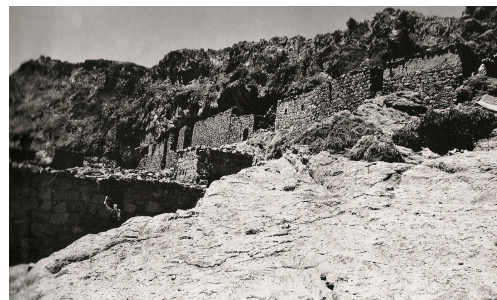
fig. 60 construções que se abrigam dentro da montanha, lémen
