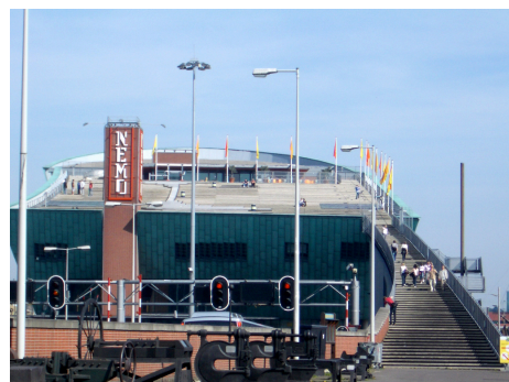
fig. 130 NEMO - túnel e praça
