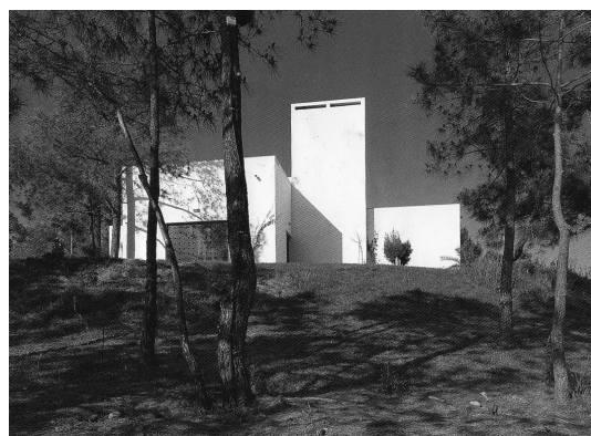
[75] Casa em Tavira, vista exterior, 1991-1996.
