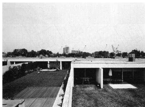
[137] Casas-pátio de Matosinhos, vista exterior, 1991.
