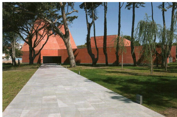
[14] Casa das Histórias, vista do acesso principal.
