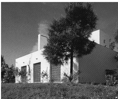
[74] Casa em Tavira, vista exterior, 1991-1996.
