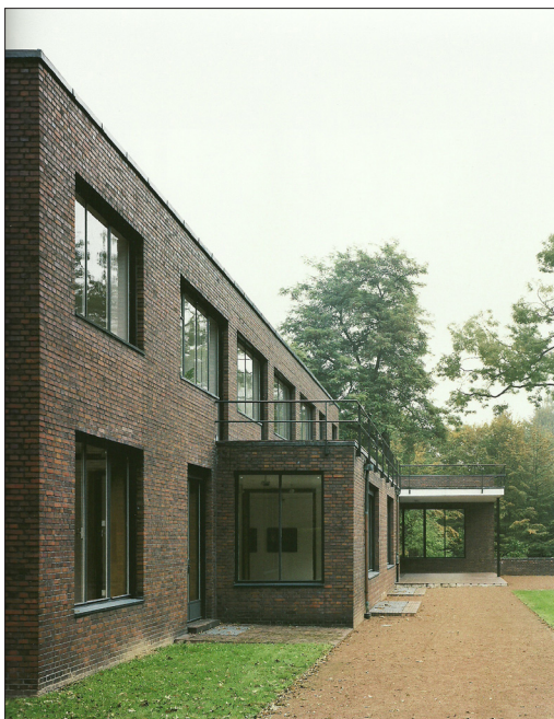
[190] Mies van der Rohe, casa Esters, vista exterior.
