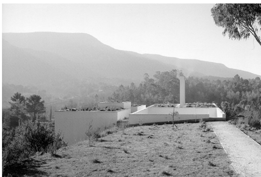
[81] Casa na Serra da Arrábida, vista do percurso de entrada.
