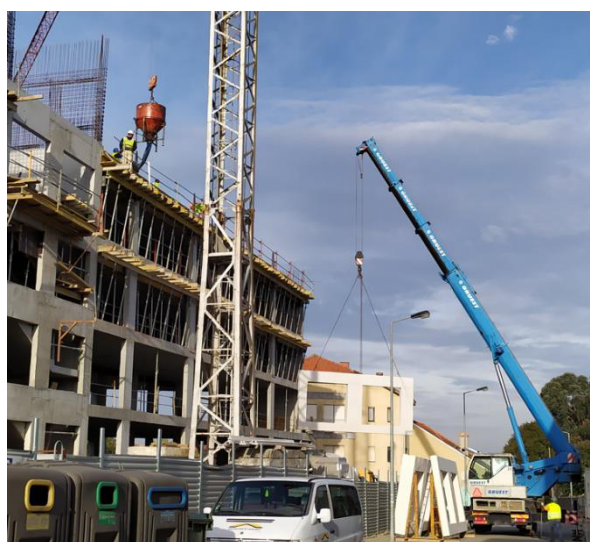
Fig. 4.20 – Elevação do painel na fachada [47]
