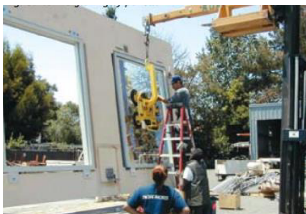
Fig. 3.31 – Instalação do vão envidraçado no painel [5]
