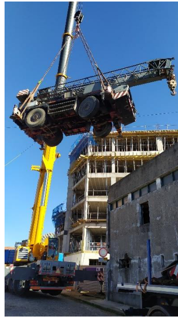
Fig. 4.22 – Grua de 30ton. de capacidade a ser elevada pela grua de 100ton [47]
