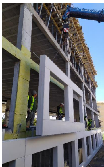
Fig. 4.19 – Equipa de montagem do painel [47]
