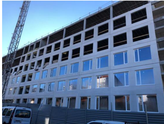
Fig. 4.26 – Colocação dos vãos envidraçados no alçado norte [47]
