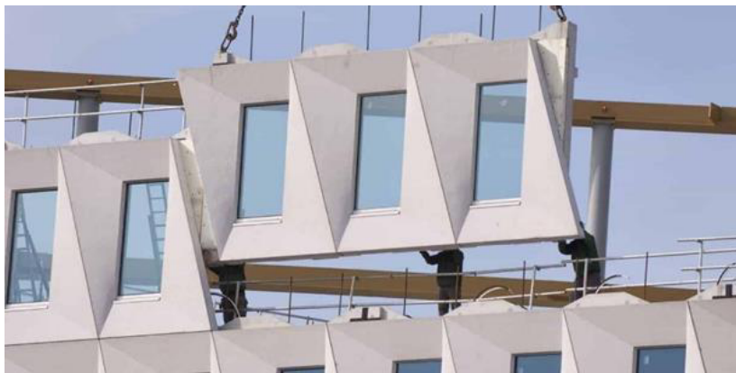
Fig. 3.36– Colocação do módulo do painel pré-fabricado de fachada [43]
