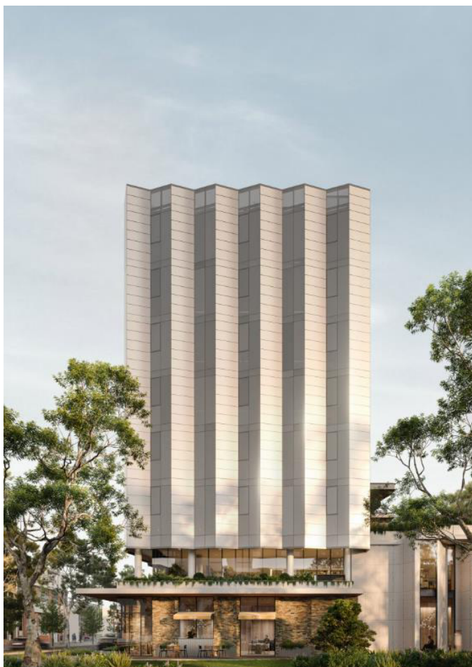
Fig. 3.39 – Edifício “550 Spencer” que contará com mais de 1.000 painéis solares na sua fachada.
