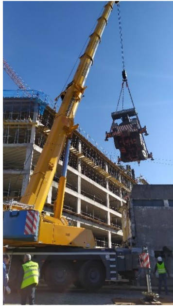
Fig. 4.21 – Elevação da grua telescópica para a zona de estaleiro posterior [47]
