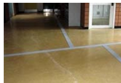
Fig. 45 Estrutura amovível indicadora de percursos num edifício público
