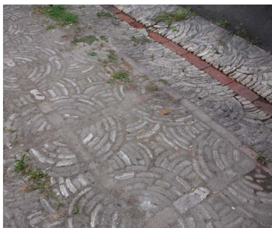
Pavimento exterior junto à casa
