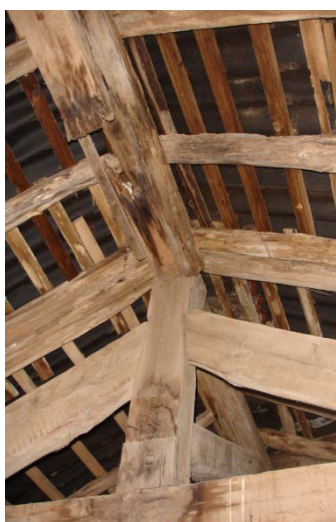
Casa - - Estrutura do telhado
