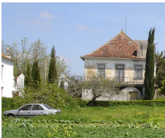
Casa – vista SO
