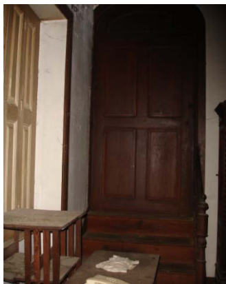
Casa – Acesso ao sótão
