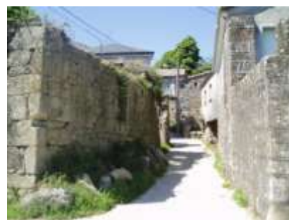
59. Casa da Demétria – fachada Este
