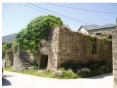
60. Casa da Demétria – fachadas Este e Sul
