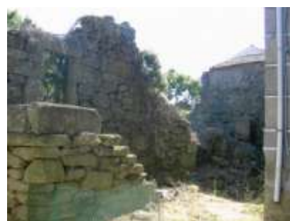
57. Casa da Parauta – acesso ao piso superior
