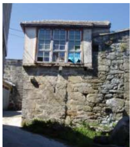
49. Fachada Sul – Casa do padre
