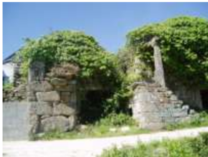
61. Casa dos Pizarras – fachada Sul
