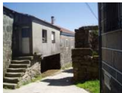
52. Fachada Oeste – Casa da vizinha
