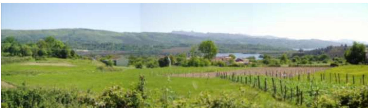
45. Vista panorâmica voltada para a barragem das Conchas
