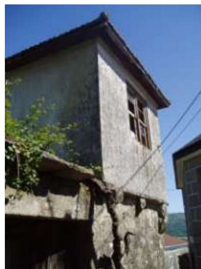
50. Fachada Oeste – Casa do padre Portão de acesso ao espaço privado
