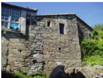
48. Fachada Sul – Casa do padre
