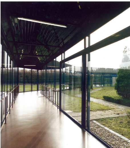
fig. 34: Corredor de deambulação
