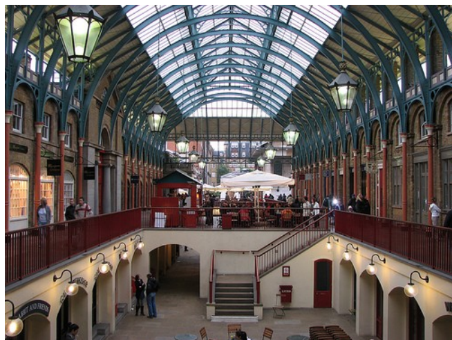
Fig. 46 Convent Garden actualmente
