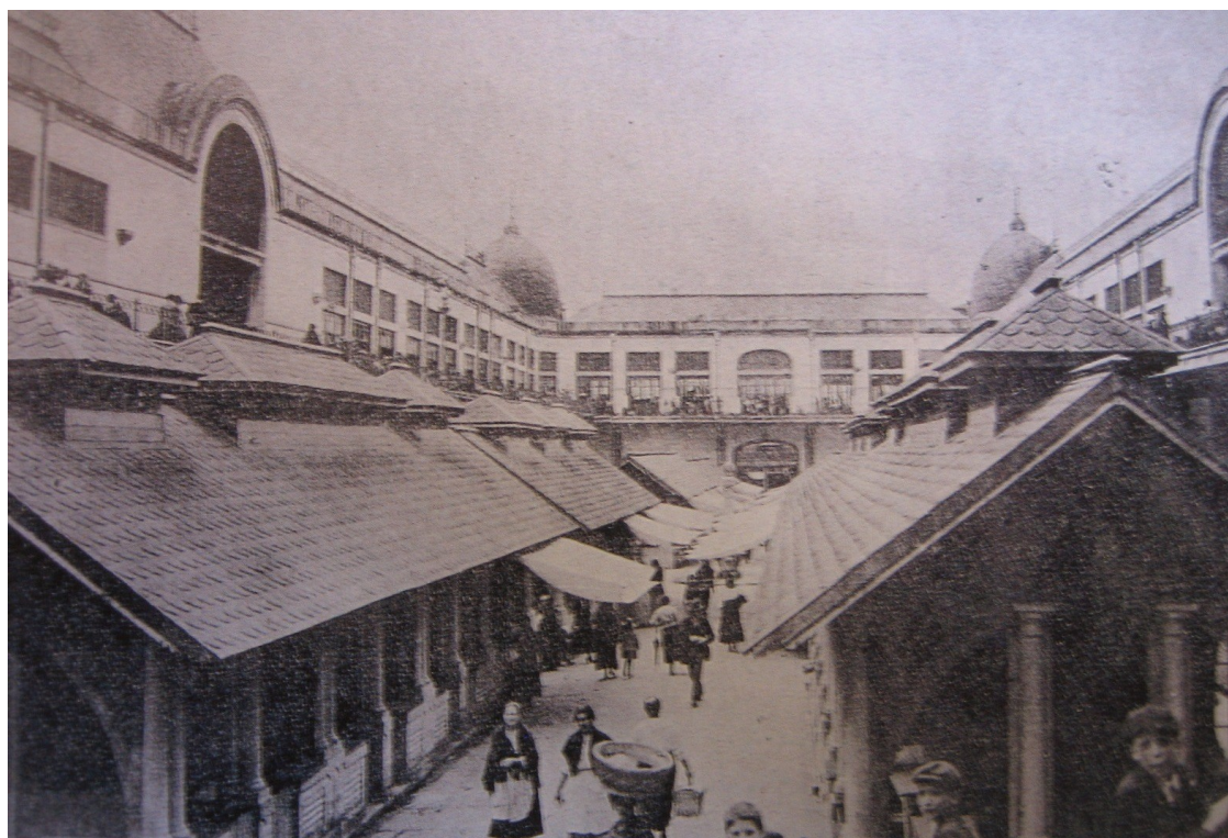
Fig 21 Vista interior do Mercado do Bolhão
