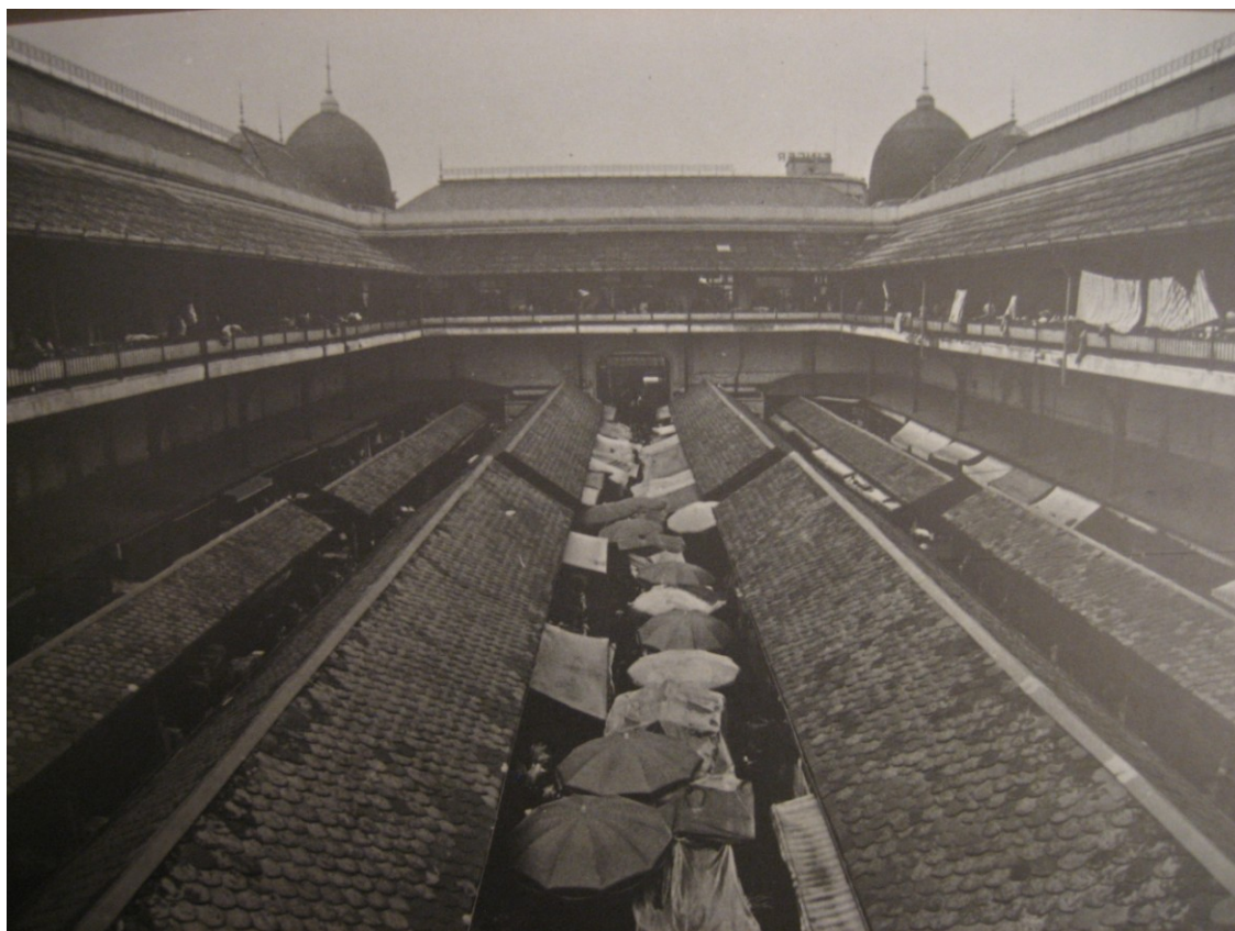
Fig 22 Vista interior do Mercado do Bolhão - galeria coberta
