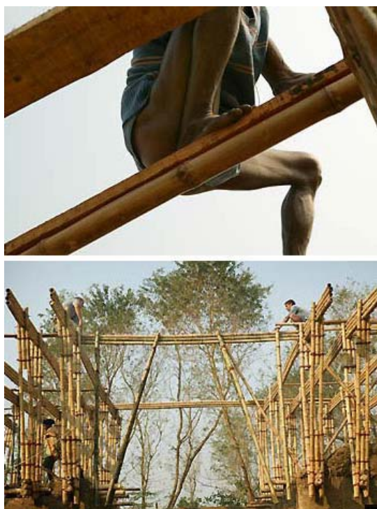
Fig. 6 – Pormenor da construção (em cima) e estrutura em bambu (em baixo).
