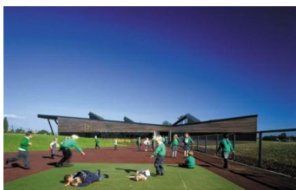
Fig. 31 - Espaço de recreio exterior na escola primária Notley Green, Inglaterra.
