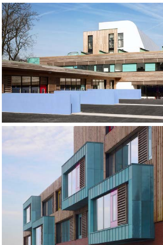
Fig. 100 - Combinação expressiva de materiais, cores e texturas. Centro escolar S. Francisco de Assis, Liverpool, Inglaterra.
