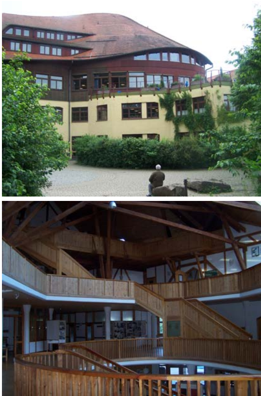
Fig. 88 - Grau elevado de complexidade no exterior (em cima) e átrio interior central. Centro escolar Waldorf, Überlingen, Alemanha (Wilfried Ogilvie).
