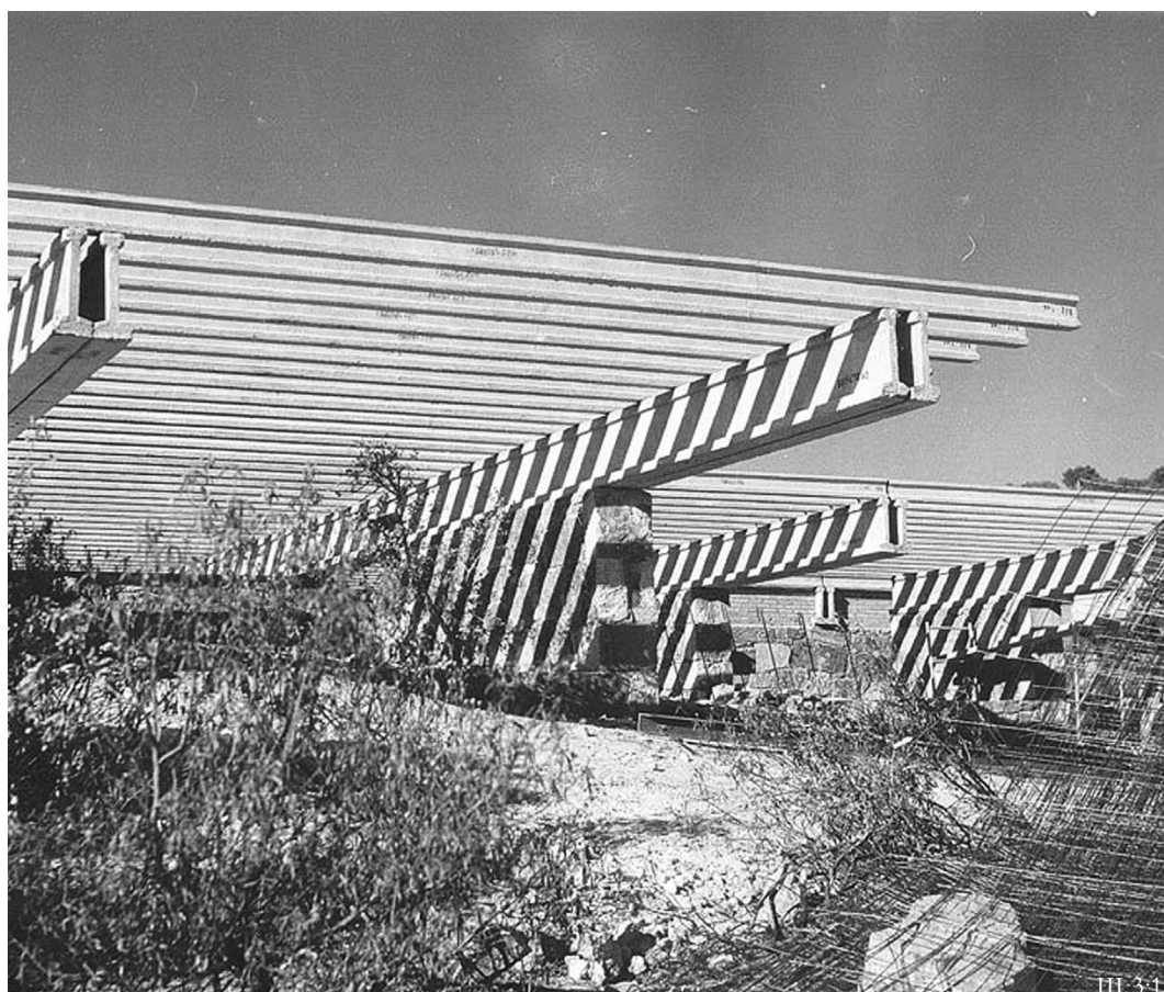
III.3:1. Casa de Villaseñor em fase de construção
