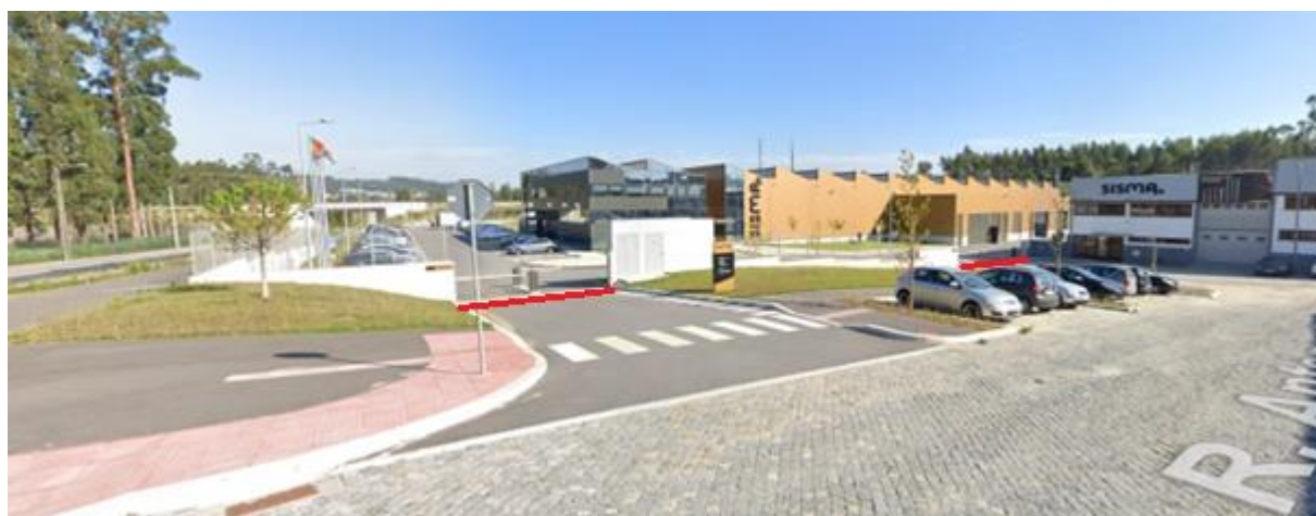
Figura 14 - Edifício Existente (Street View)
