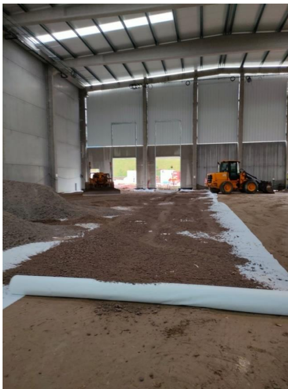
Figura 53 - Aplicação de Geotêxtil e Tout-venant
