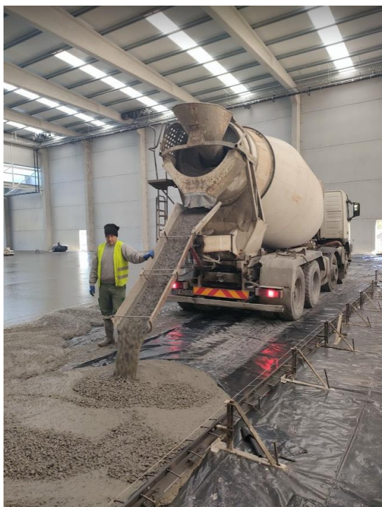
Figura 57 - Betonagem do Pavimento
