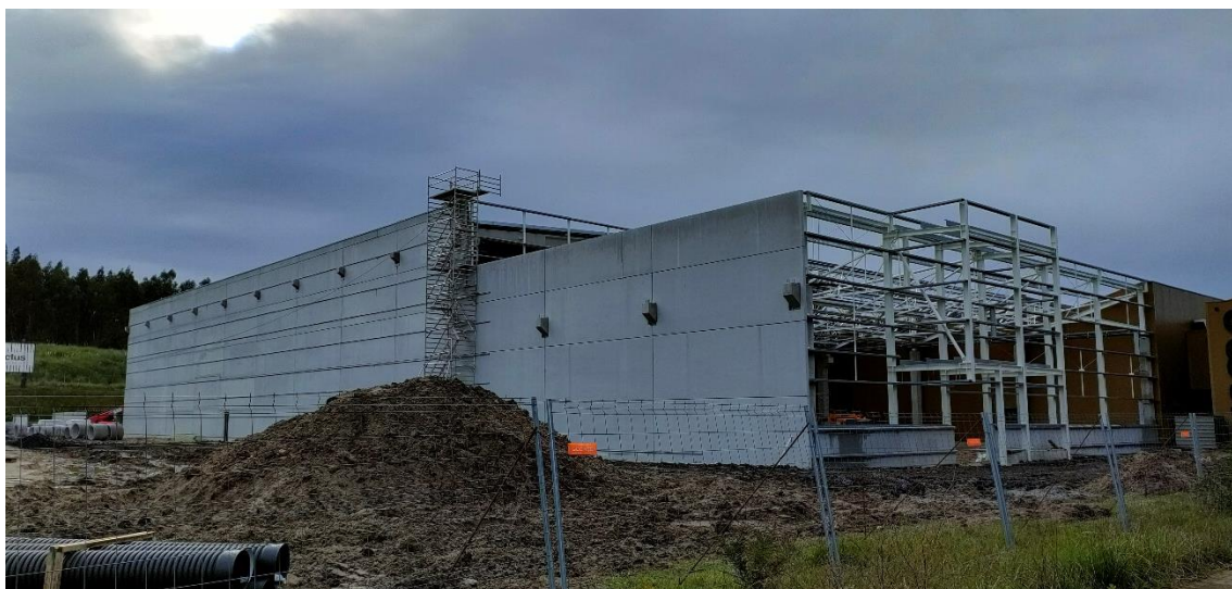
Figura 21 - Estrutura em metal e betão pré-fabricado
