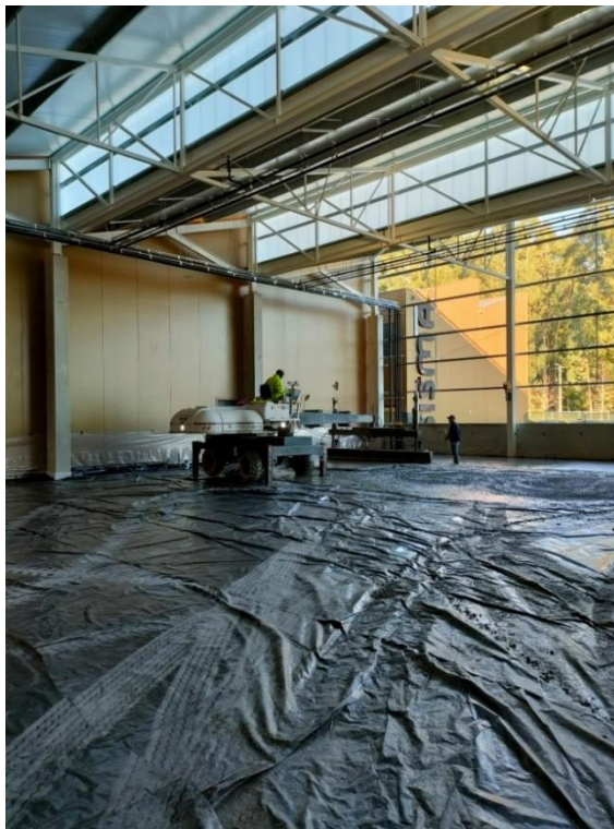
Figura 54 - Aplicação da camada plástica
