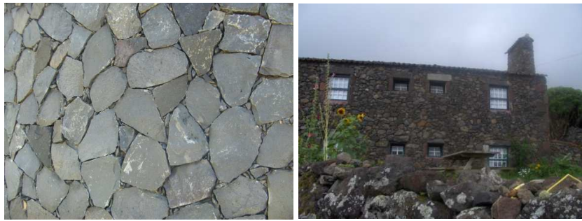
Figura 32_ Pedra Basáltica Laminada | Habitação em pedra (APA)
