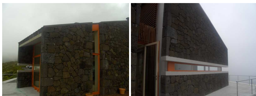
Figura 35_ Casa de apoio à montanha do Pico (APA)
