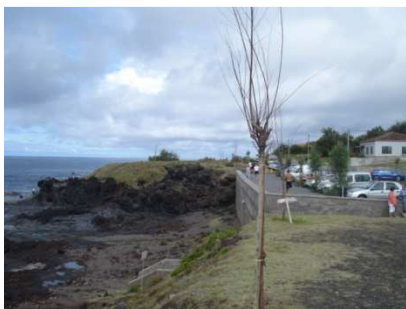
Figura 37_ Construções junto ao mar (APA)
