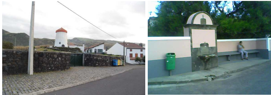
Figura 29_ Muro em basalto | Fontanário (APA)
