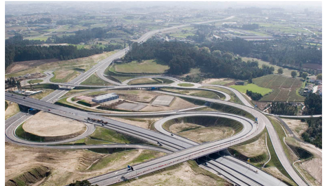
Fig. 21 - Nó viário (Aeroporto Francisco Sá Carneiro).
