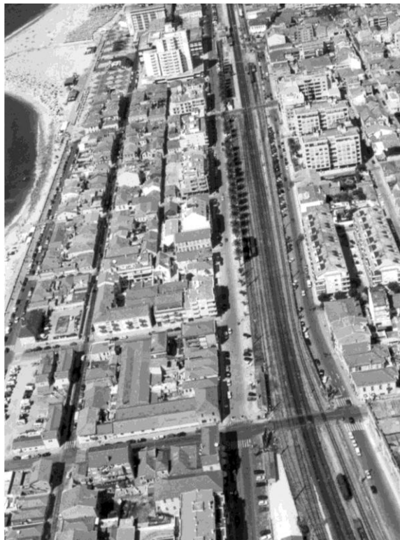
94_ Linha férrea antes do seu enterramento
