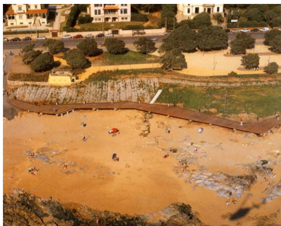
67_ Passadiço junto ao mar, a Sul do parque
