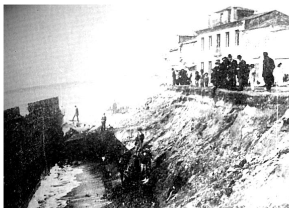
35_ Destruição do muro de defesa
