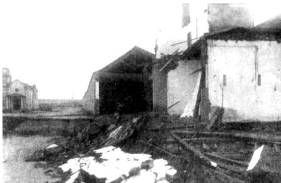
36_ Destruição parcial da fábrica de conservas (1947)
