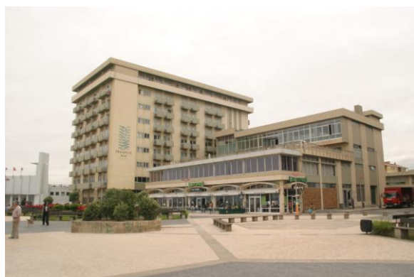
81_ Praça e edifícios adjacentes
