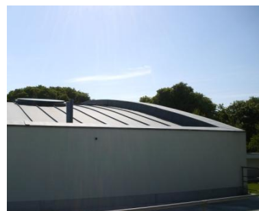
Figura 100. Cobertura do auditório em zinco.
