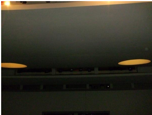
Figura 106. Tecto absorvente com inclinação.
