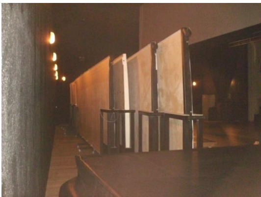
Figura 104. Concha acústica desmontável.
