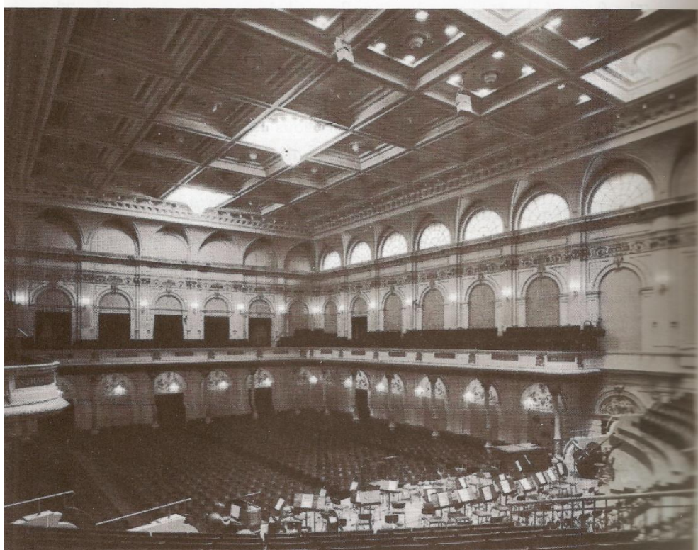
Figuras 63 e 64. fotos da Amsterdam Concertgebouw (vista do palco e do balcão).
