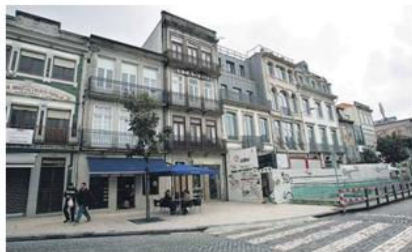
Figura 20: Intervenção em Carlos Alberto, ainda em fase de obra. (fonte: Edifer/ SRU PortoVivo)
