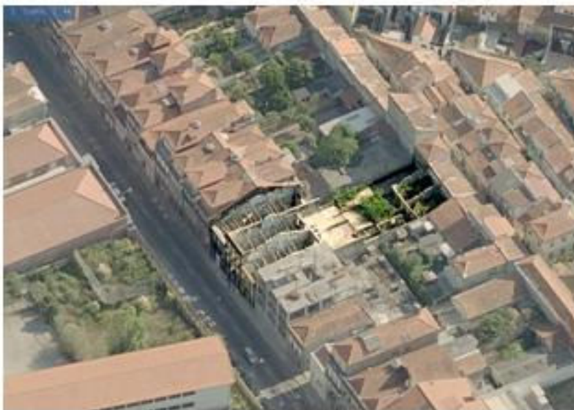
Figura 41: Perspectiva aérea sobre os lotes, já em processo de demolição
