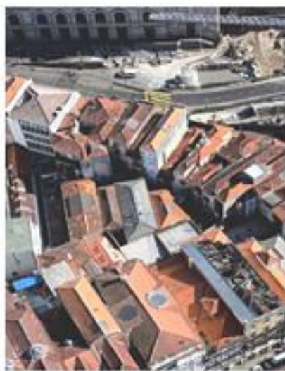
Figura 13: Registo fotográfico do miolo construído no interior do logradouro do Quarteirão das Cardosas. (fonte SRU)
