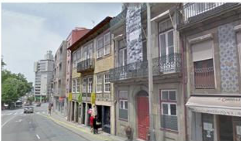
Figura 46: Perspectiva do edifício a partir da Rua de D. Manuel II.
