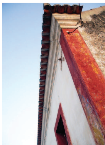
37. Detalhe da moldura e da cornija.
