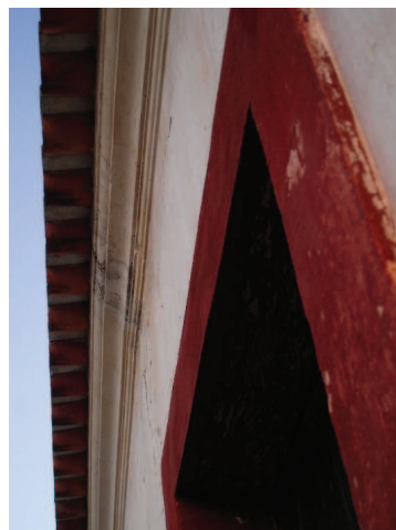
35. Detalhe da moldura e da cornija.
