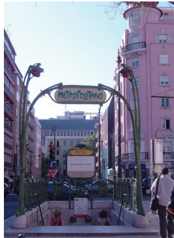
45. Estação de Metro de Picoas, Lisboa
