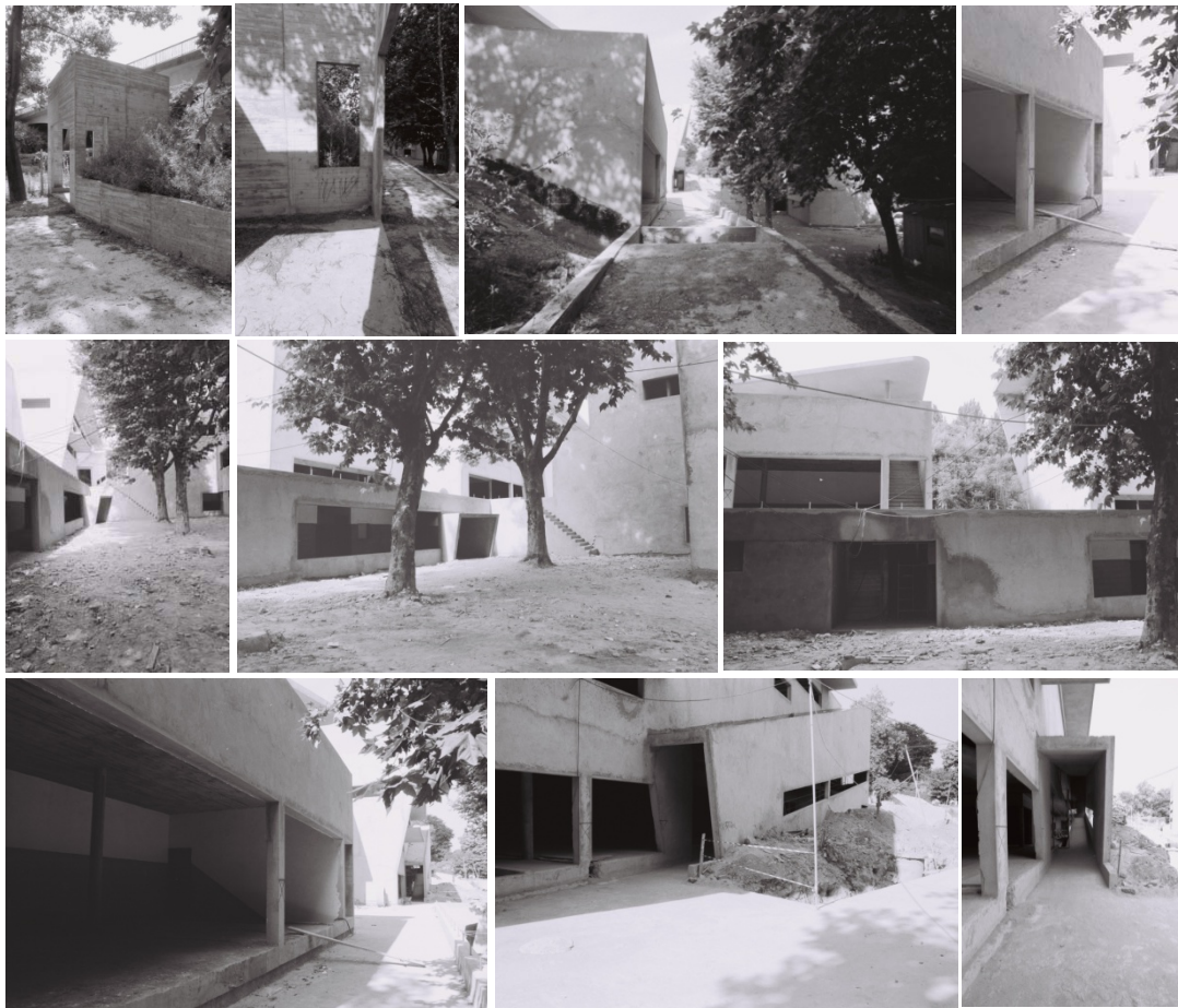
Figura 2.12. (sequência superior) Entrada pela “Porta Oeste” da faculdade e bar (piso superior). (sequência intermédia) Porta de entrada para o átrio de distribuição do piso 0 e bar (piso inferior). (sequência inferior) Porta “principal” de acesso ao átrio da secretaria e a outros serviços de recepção (piso 1) Fotografias de obra. Cortesia de Teresa Siza.
