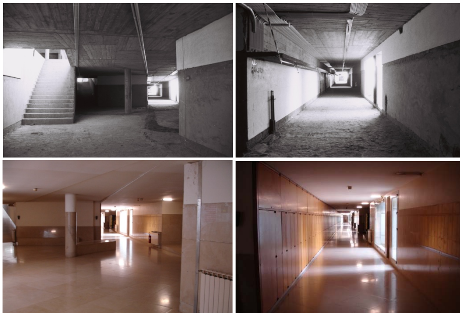
Figura 2.17. (esquerda) Átrio de distribuição do piso 0. (direita) Galeria semi-enterrada de acesso às torres. Fotografias de obra. Cortesia de Teresa Siza. Fotografias da autora.
