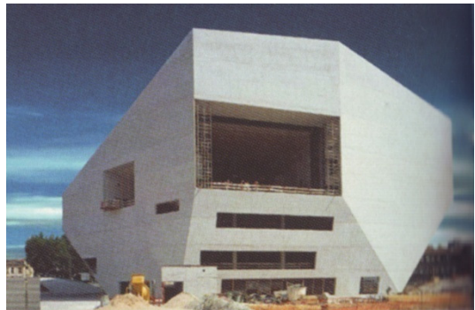
36. Casa da Música em construção
