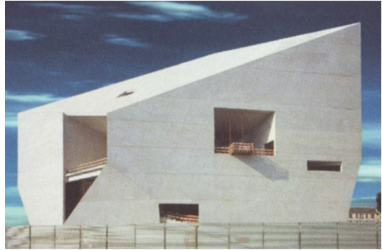
35. Casa da Música em construção
