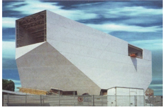
38. Casa da Música em construção
