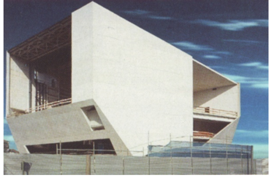
34. Casa da Música em construção
