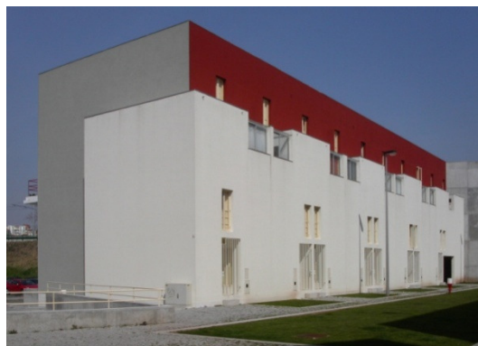
2. Bloco Habitacional da Bouça, utilização de formas puras e racionais, 2007
