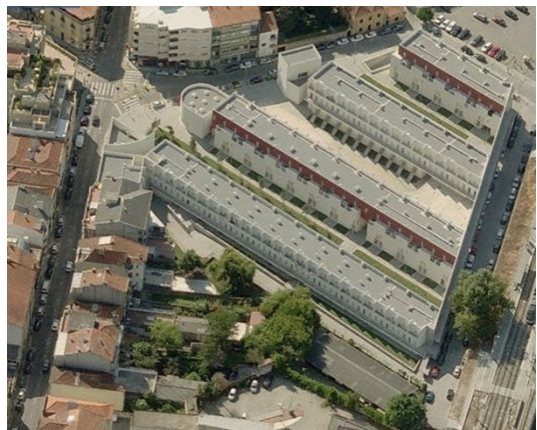
6. Vista aérea do espaço interior residual do quarteirão pré-existente
