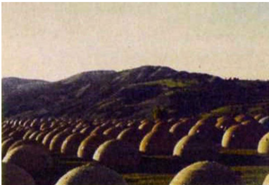
Fig. 65. Iglus de poliuretano Masaya, Nicarágua. Estruturas experimentais doadas pela Cruz Vermelha da República Federal Alemã e pela Bayer, 1972.
