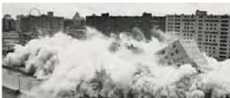
Fig. 48. Demolição parcial de Pruitt-Igoe. St. Louis, 1972.
