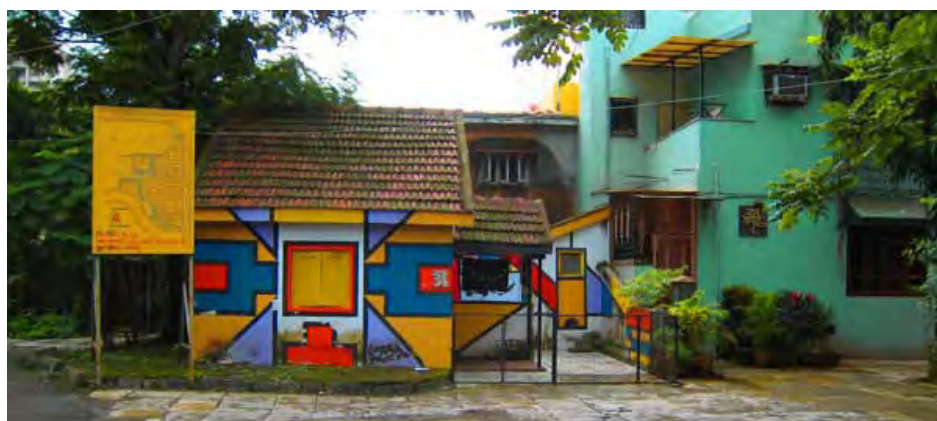
Fig. 92. Habitação incremental em Belapur, habitação original (lado esquerdo) e habitação reconstruída (lado direito). 2008.
