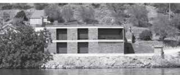
da obra com João e Eliseu Gonçalves Senhora da Ribeira
