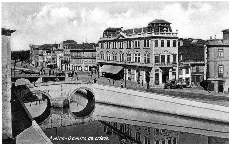
As duas pontes e o novo Hotel Arcada, na versão de 1937
