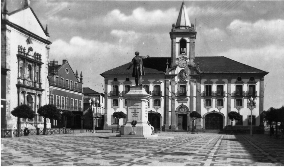
Edifício dos Paços do Concelho depois das alterações introduzidas pelo projecto de 1923
