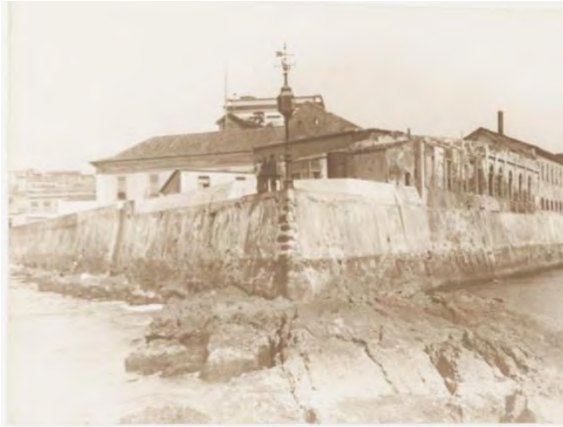
[1.14] MALTA, Augusto. (1921). Ponta do Calabouço: Resquícios do edifício subterrâneo que abrigava a antiga prisão de pessoas escravizadas.
