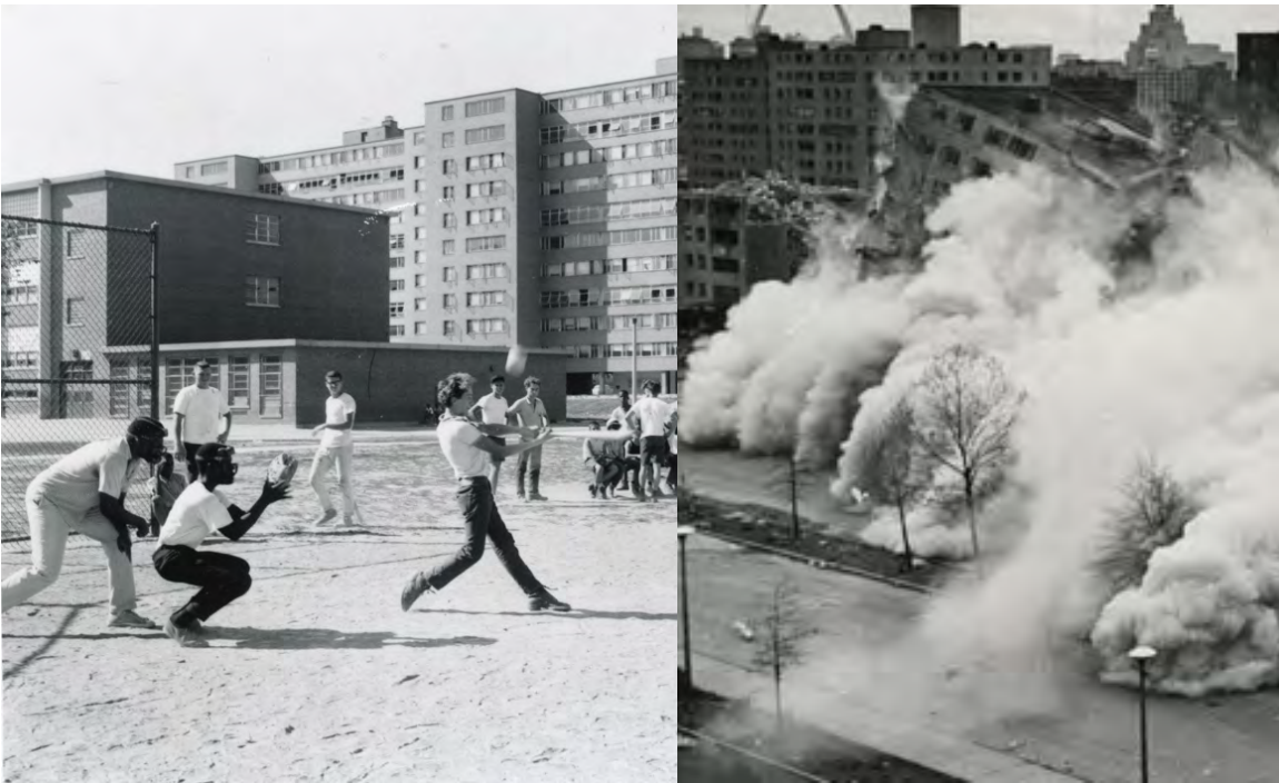
[1.23] (esq.) Jovens a usufruir do espaço público próximo ao edifício Pruitt-Igoe. [1.24] (dir.) Demolição do edifício Pruitt-Igoe.
