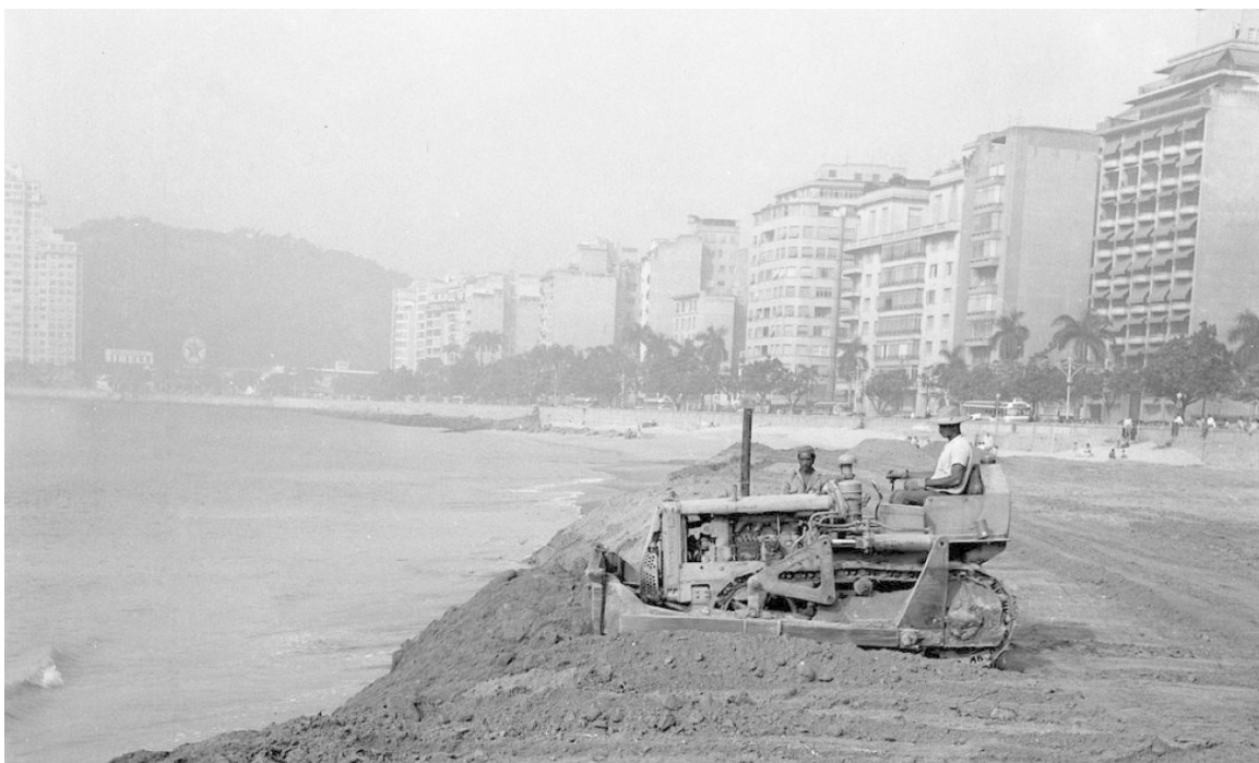
[1.32] Trabalhos na operação de aterro na Praia do Flamengo (1959). Fonte: Agência O Globo (2018).
