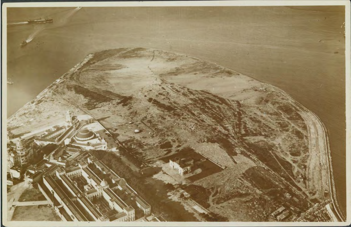
[1.9] Imagem aérea da zona conhecida por Ponta do Calabouço. Na imagem vê-se uma extensa zona de terra que se sobrepõe a antiga prisão, o material que conforma esta zona de aterro é resultante da demolição do Morro do Castelo.
