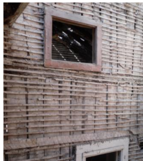
Figura 3.17. – Parede em tabique, Bastos (2019)
