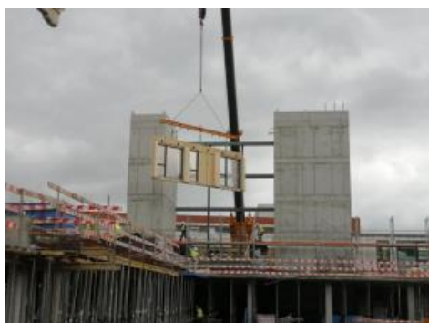
Figura 4.7. – Fase construção hotel B&B Guimarães (Figura de Grupo Casais, 2022, www.casais.pt .)
