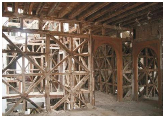
Figura 3.16. – Estrutura Gaiola Pombalina, Lopes (2012)
