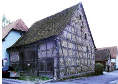
Figura 3.18. – Construção em Fachwerk, Wittmann (2016)
