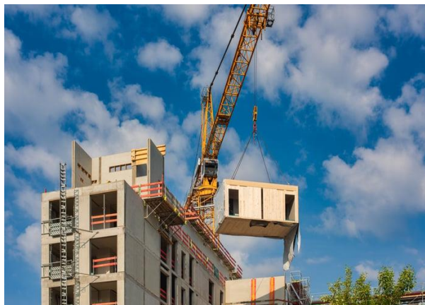
Figura 2.9. – Construção modular, Off-site
