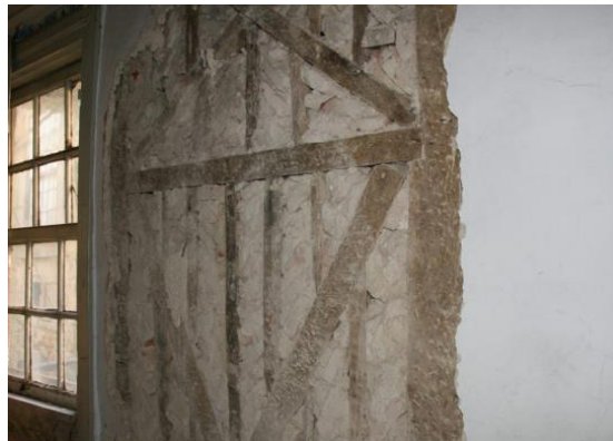
Figura 3.19. – Parede em enxaimel, Bastos (2019)
