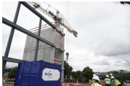
Figura 4.8. – Fase construção hotel B&B Guimarães (Figura de Grupo Casais, 2022, www.casais.pt .)
