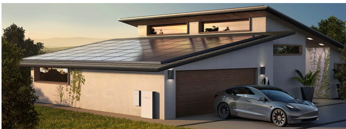
Figura 2.3: Exemplo de habitação integrada na central, com Powerwall e sistema fotovoltaico [26]
