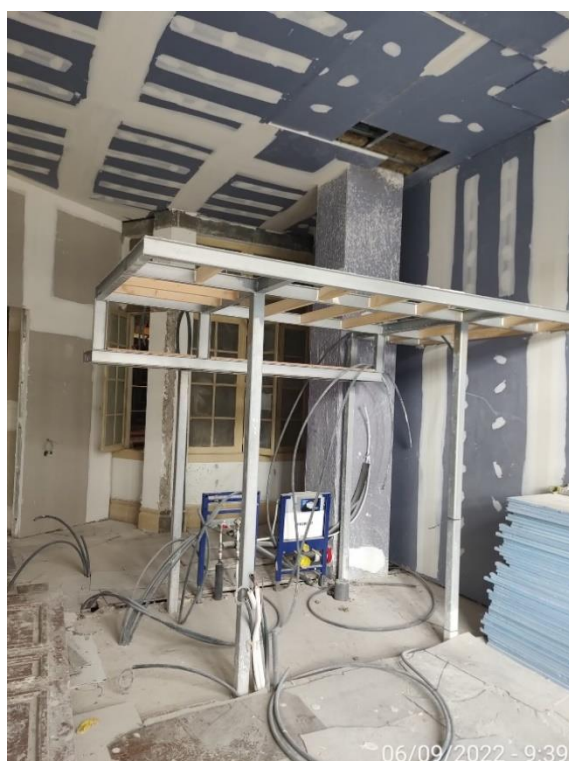
Parede e tecto em pladur
