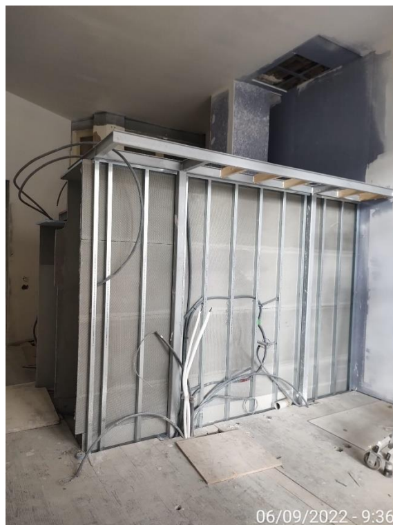
Instalação de placas de pladur
