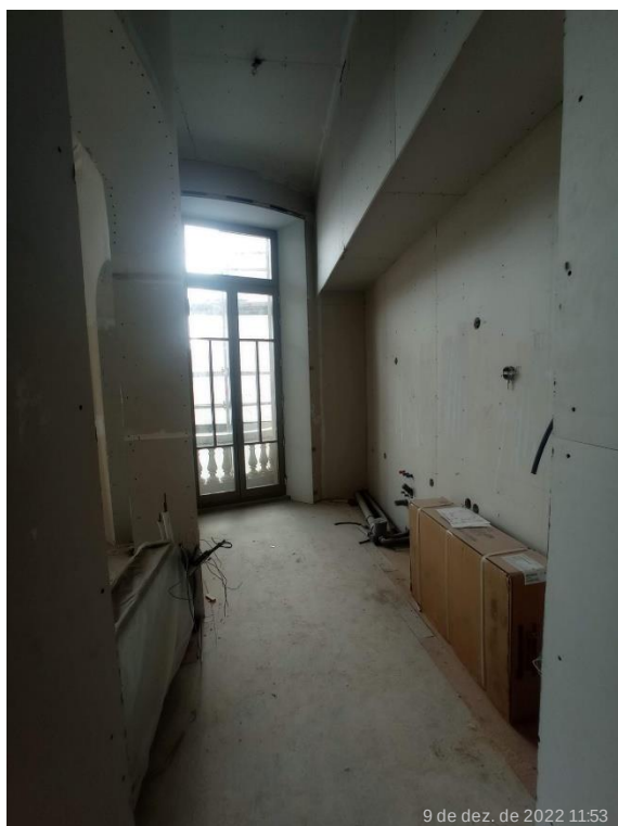
Parede e tecto em pladur
