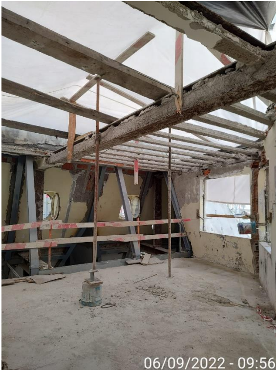
Cobertura existente em fase de desmontagem, piso 6
