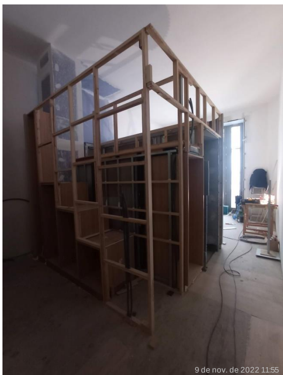
Estrutura de madeira
