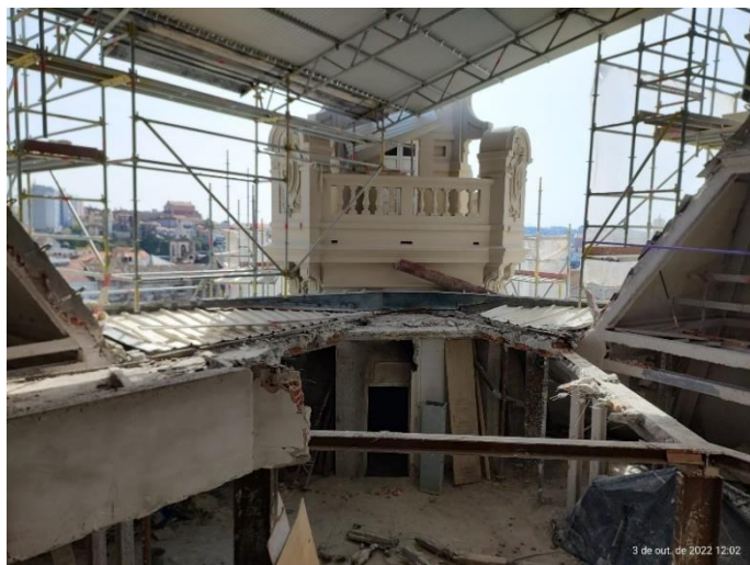
Demolição do piso 6
