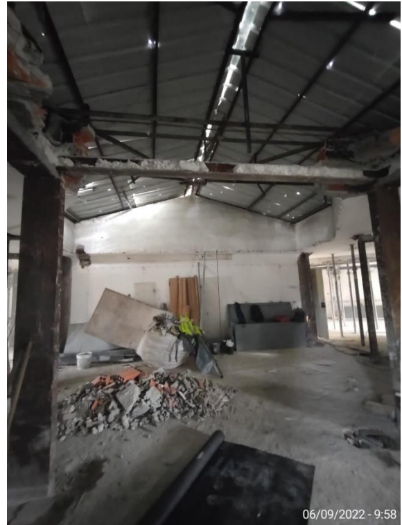
Cobertura existente em fase de desmontagem, piso 5
