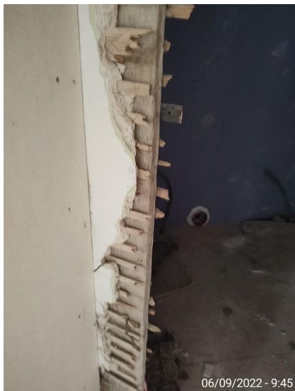
Parede de tabique existente
