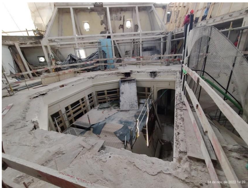
Figura 4.8 – Demolição de parte da laje do piso 5.
