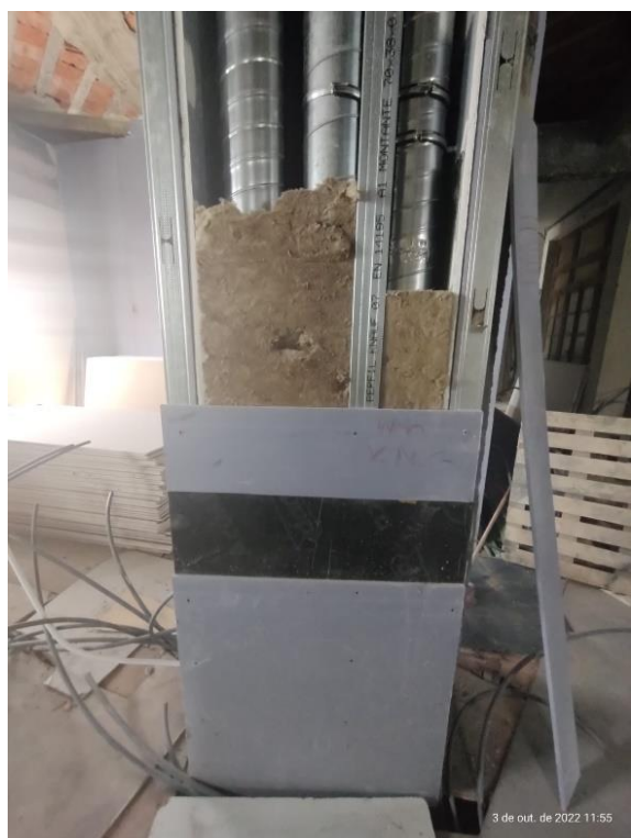
Estrutura das paredes novas
