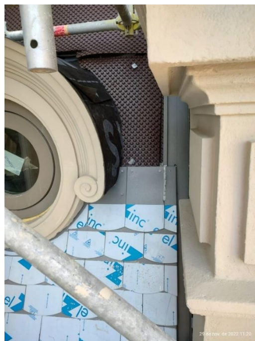
Cobertura nova em zinco
