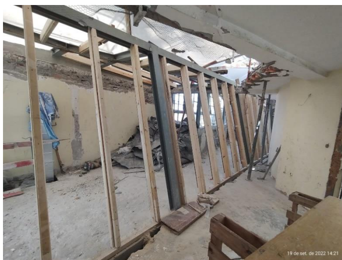
Estrutura de madeira para nova cobertura do piso 6
