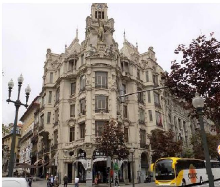
Figura 4.2 – Fotografia da fachada do Edifício na Avenida dos Aliados antes da intervenção, Fonte: Arquivos Fotográficos da SOPSEC.
