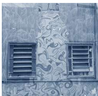
FIGURA 71. Detalhe da fachada e ornamento em argamassa.
