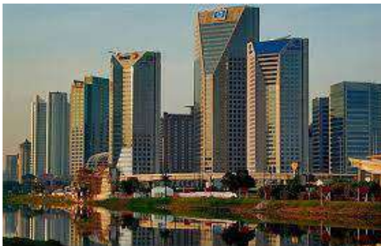
FIGURA 25 - Centro Empresarial Nações Unidas, inaugurado em 1999. Situado entre as Avenidas Nações Unidas e Luís Carlos Berrini.
