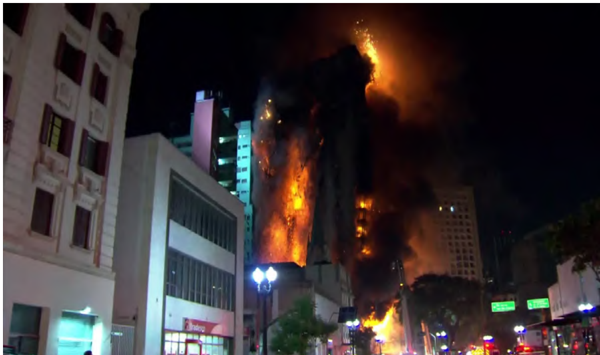
Prédio desaba durante incêndio no Centro de SP — Foto: Reprodução/TV Globo
