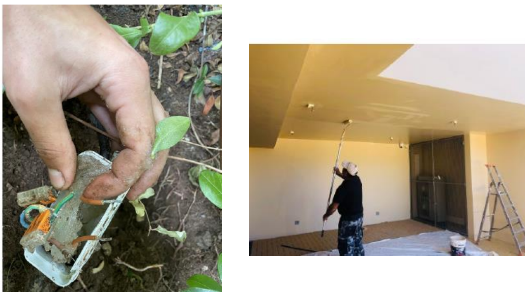
Figura 13- Reparação dos focos de luz
