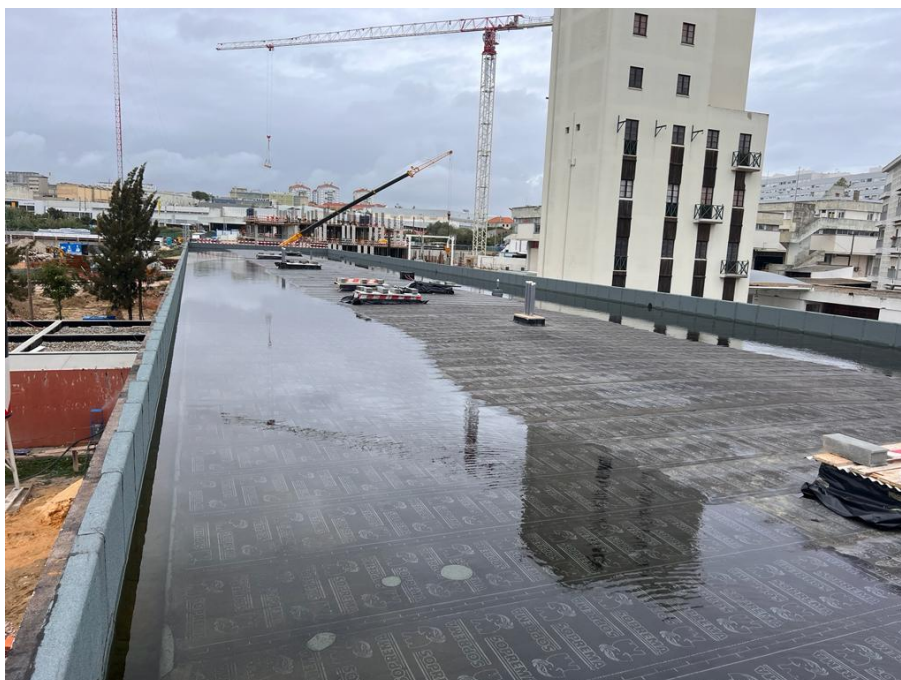
Figura 17- Ensaio de carga com água feito pela Empresa
