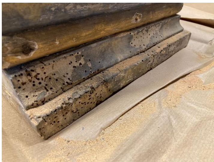
Figura ApD14 – Sinais de infestação recente num plinto – orifícios e serrim. © Diana Ribeiro, 2022.
