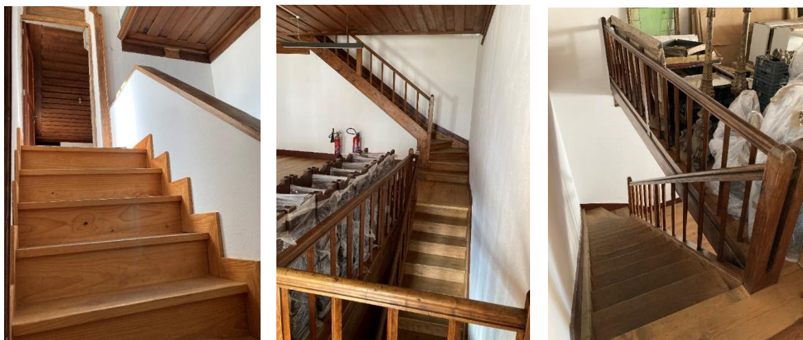
Figuras 5, 6 e 7 – Perspetiva das escadas de acesso à reserva da Igreja de Santa Clara do Porto.
