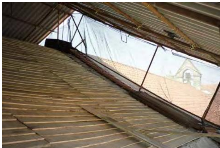
Figura 3 – Detalhe da cobertura do edificado durante a intervenção da DGMN, c. 2001.
