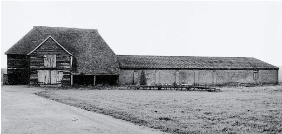
Figura 22 Vista exterior da casa antes da reabilitação
