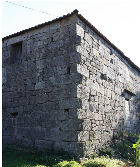
Figura 66 e 67 Pilares em granito e em madeira
