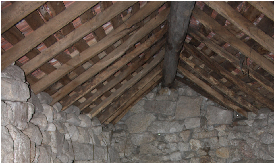
Figura 64 Estrutura de cobertura em madeira
