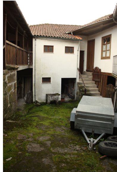
Figura 80 e 81 O alçado e o pátio interior da Casa do Carvalho em cimadevila na aldeia de Chacim
