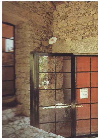
Figura 21 Ambiente interior. No canto vê-se o móvel curvo, tema que Siza repete em toda a intervenção
