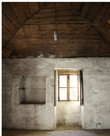
Figura 62 e 63 Interior da cozinha (corpo A) e da sala (corpo B) com tecto de masseira
