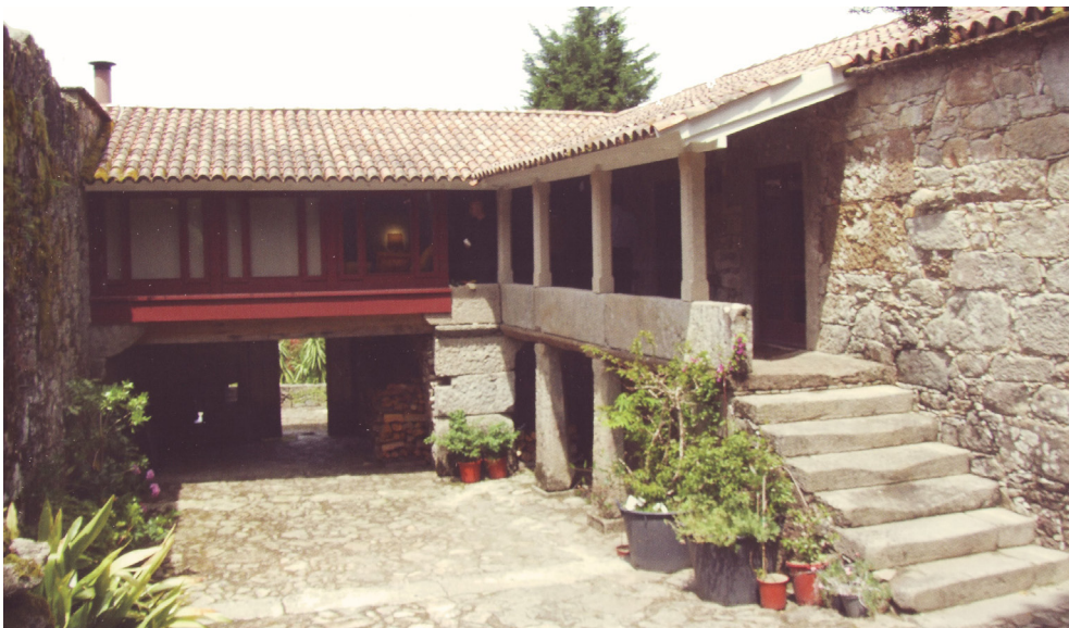
Figura 15 Vista do pátio para a Casa de Pardelhas
