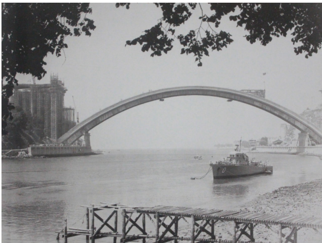
27. O porto de Leixões 28. A construção da Ponte da Arrábida
