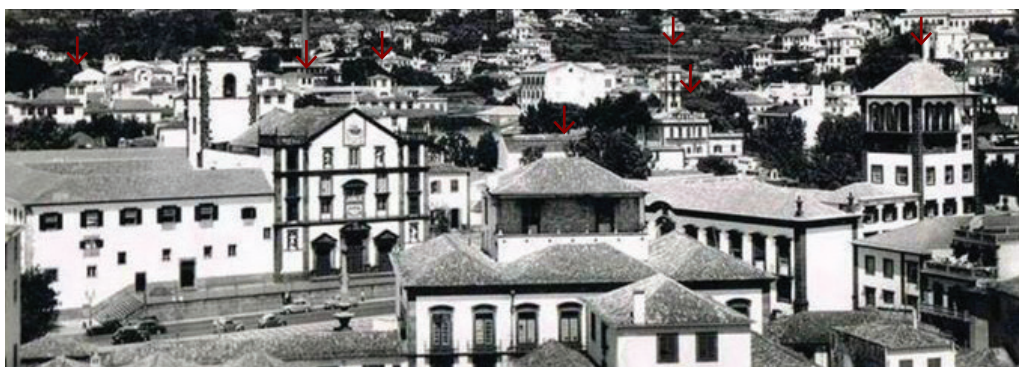
291- Torres de ver o mar, nas proximidades do largo do Colégio, Funchal. (s.d.)
