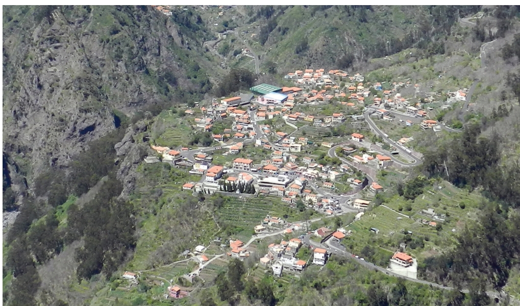
130- Sítios da Achada e Casa Próximas, Curral - edificado inserido em estrutura agrícola e meio serrano.
