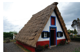
111- Casa de Santana, de meio-fio.
