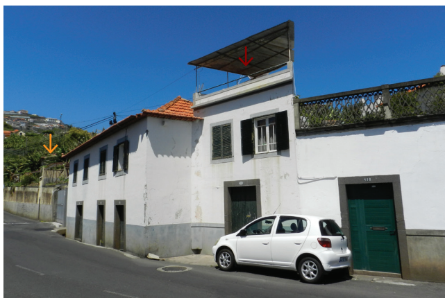
292- Casa de Prazer, casa com loja e balcão, trecho da antiga estrada real 25.
