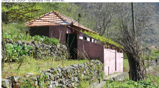
305- Casa na serra inserida em estrutura agrícola, Curral das Freiras.
