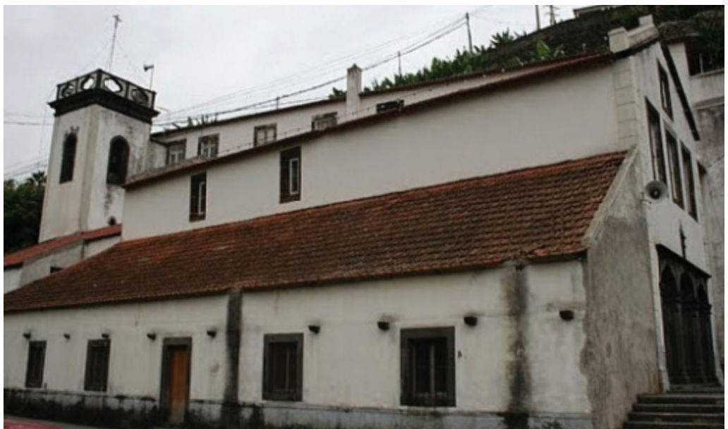
269- Convento de São Bernardino (actualmente em obras).
