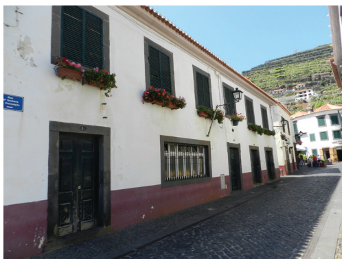
284 e 285- Edifícios da rua Direita, Câmara de Lobos.
