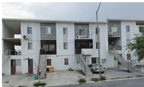
Figura 92 | Complexo de Monterrey, actual
