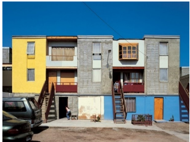
Figura 83 | Vista actual da Quinta Monroy
