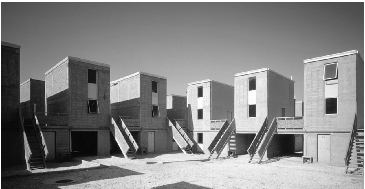
Figura 69 | Vista do complexo da Quinta Monroy, 2003
