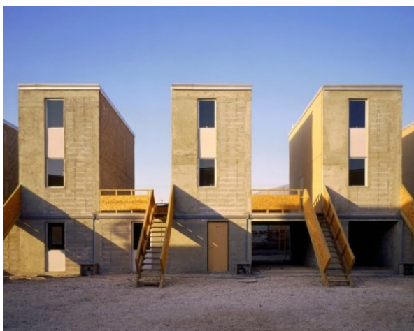
Figura 82 | Vista da Quinta Monroy, 2003
