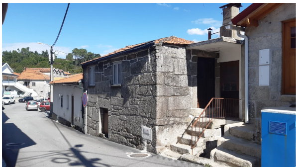
(2022) Rua Fonte Velha casa nº 160
