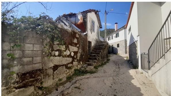
(2022) Rua Fonte Velha casa nº 90
