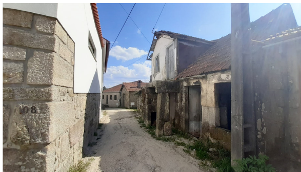
(2022) Rua Fonte Velha casa nº 90
