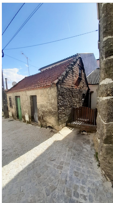
(2022) Vista sobre Casa com acrescento de inclinação no telhado na Rua da Fonte Velha
