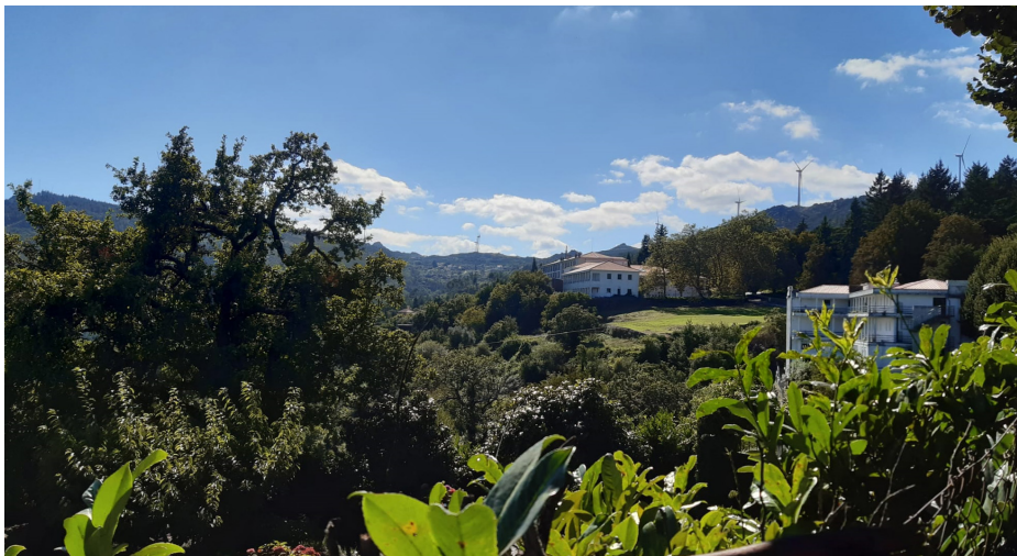
16 | P. Moreira (2022) Perspetiva sobre antigo Sanatório do Sameiro e antigo Sanatório Salazar (atual Hotel do Caramulo). A sua implantação permite a relação visual entre os dois Sanatórios ao mesmo tempo que se viram para a Serra da Estrela, permitindo simultaneamente o desenho da galeria desafogada sobre a vista, como a proteção dos ventos pela topografia de cotas superiores que os envolvem.
