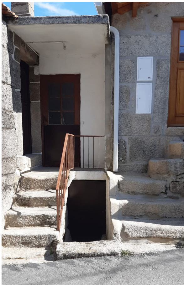
(2022) Rua Fonte Velha casa nº 160
