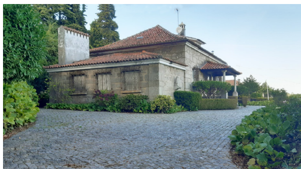
(2022) Vista sobre Casa de granito com alpendre chaminé e telhado desde Rua Cerejeiras
