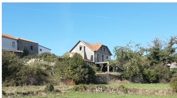
(2022) Vista sobre Casa de telhados inclinados de influência suíça desde a Rua da Escola
