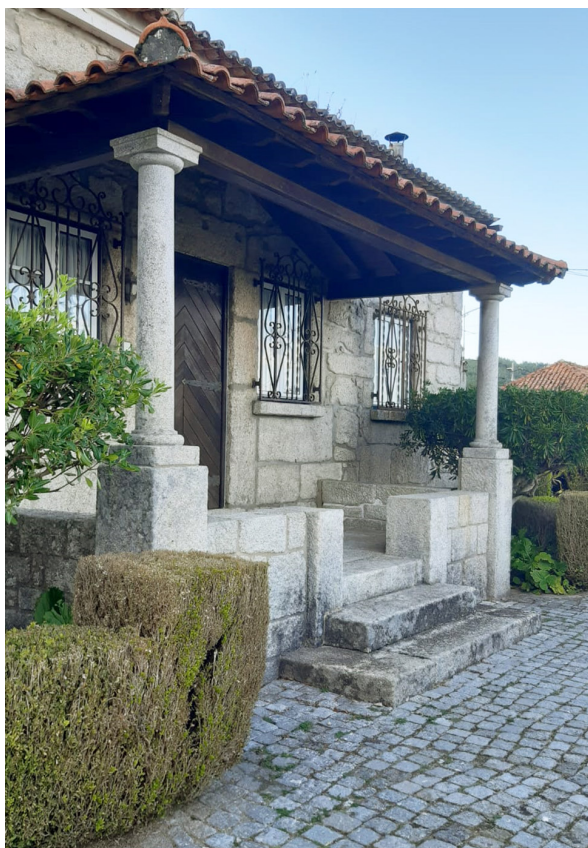
(2022) Vista sobre Casa de granito com alpendre chaminé e telhado desde Rua Cerejeiras
