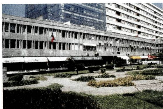
Figura 71 – Galeria fechada (rua Eugénio de Castro)
