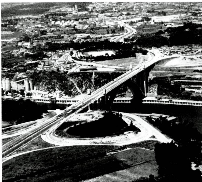
Figura 54 – Ponte da Arrábida e acessos – início dos anos 70
