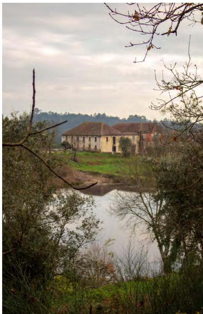
Fig.21_ Vista a partir da propriedade para a igreja Fig.22_ Relação da Casa com a igreja Fig.23_ Relação da Casa com o espaço exterior envolvente
