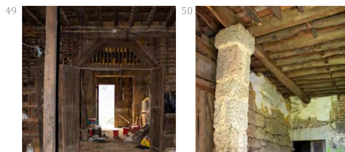
Fig.49_Pilares existentes no piso térreo do Corpo Anexo Fig.50_Piso existentes no piso -1
