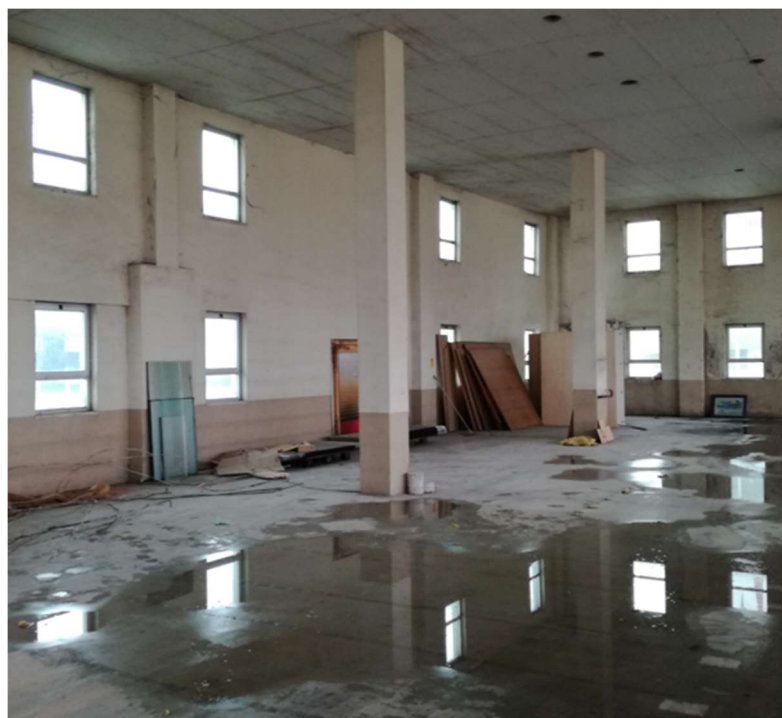
Fig. 8 – Pés-direitos do edifício original
