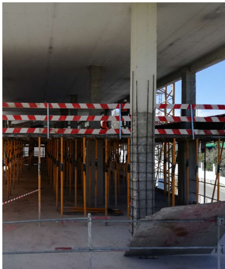
Fig. 10 – Reforço de pilares
