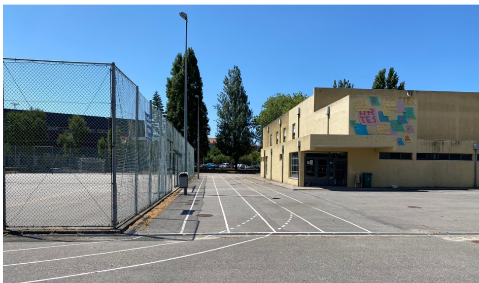
Figura 9- Pista de Atletismo Exterior da ESSH (2)
