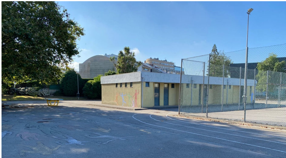
Figura 8- Pista de Atletismo Exterior da ESSH
