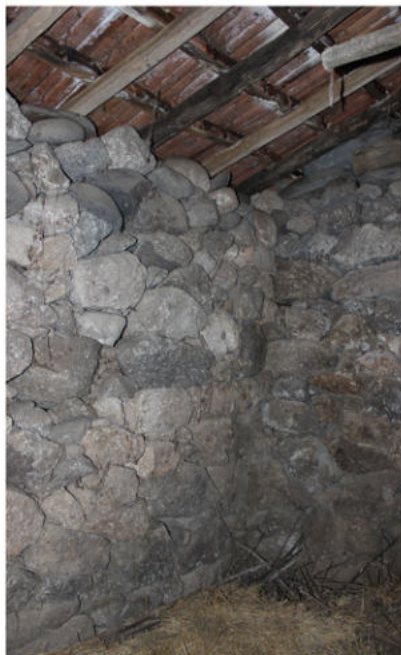
61. Encontro da cobertura com a parede
