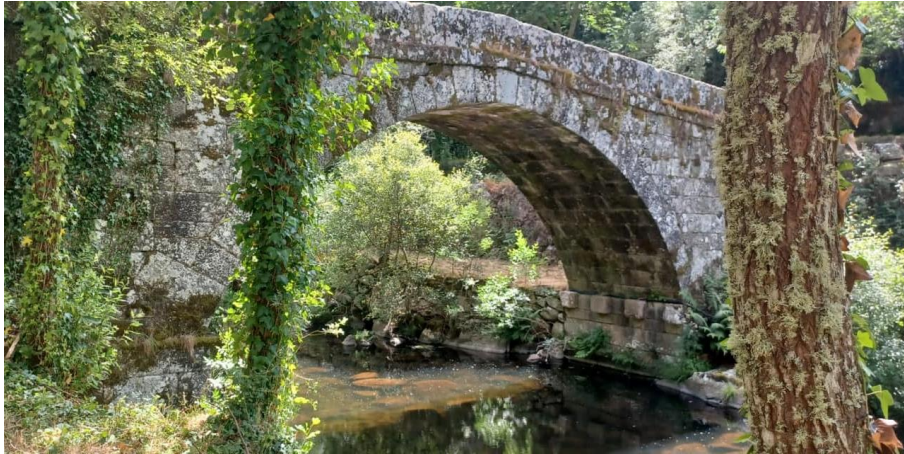
47. Ponte do Gardal
