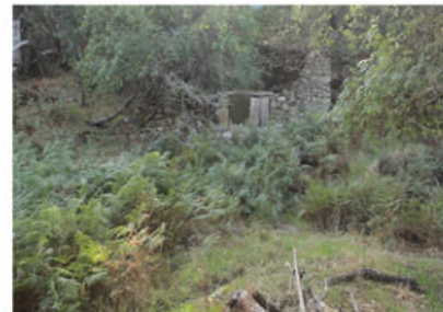
158. Ruína de casa na envolvente
