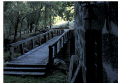
96. Ponte pedonal em madeira
