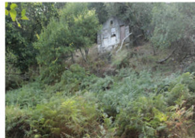
159. Ruína de casa na envolvente
