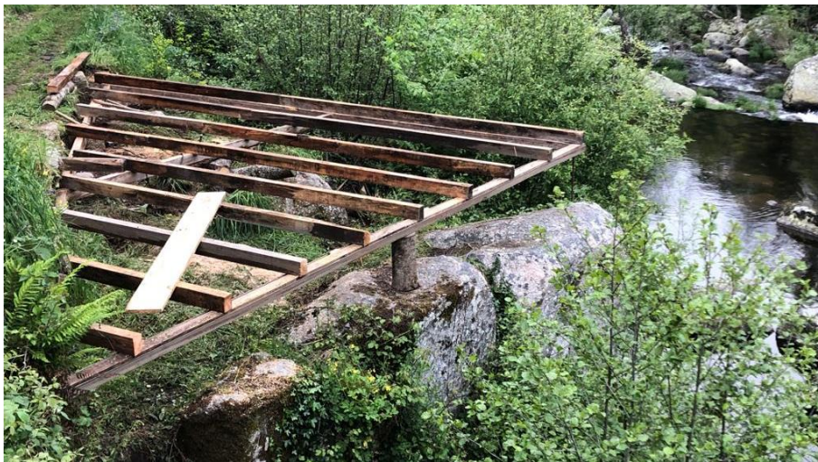
77. Palanque mira-rio - Estrutura de ferro, revestimento de madeira
