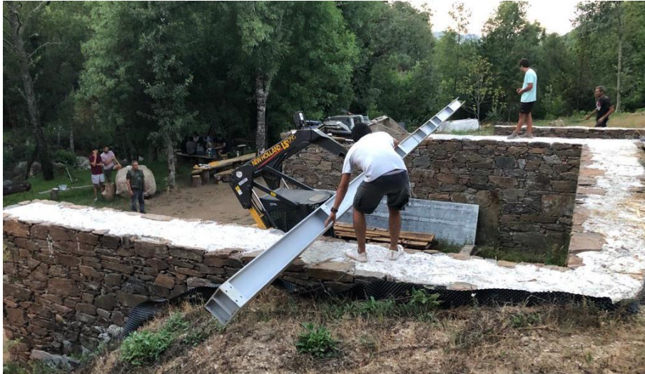
76. Primeira viga da casa do Marelo - 500kg | 12,5m
