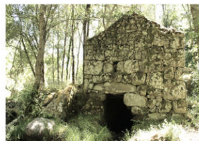
76. Pormenor do cabouco, alçado Este
