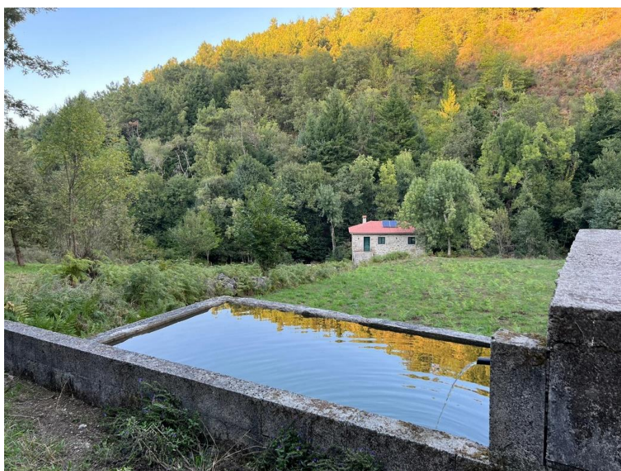
43. Tanque de Água
