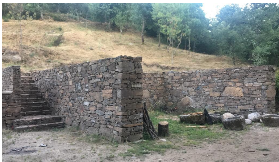
18. Reabilitação das paredes e adição das escadas laterais da Casa do Marelo
