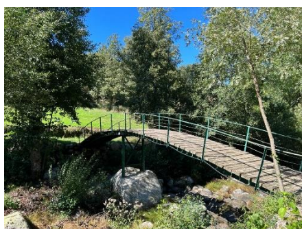
33. Ponte de Ferro
