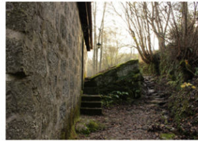
94. Escadas de acesso ao moinho
