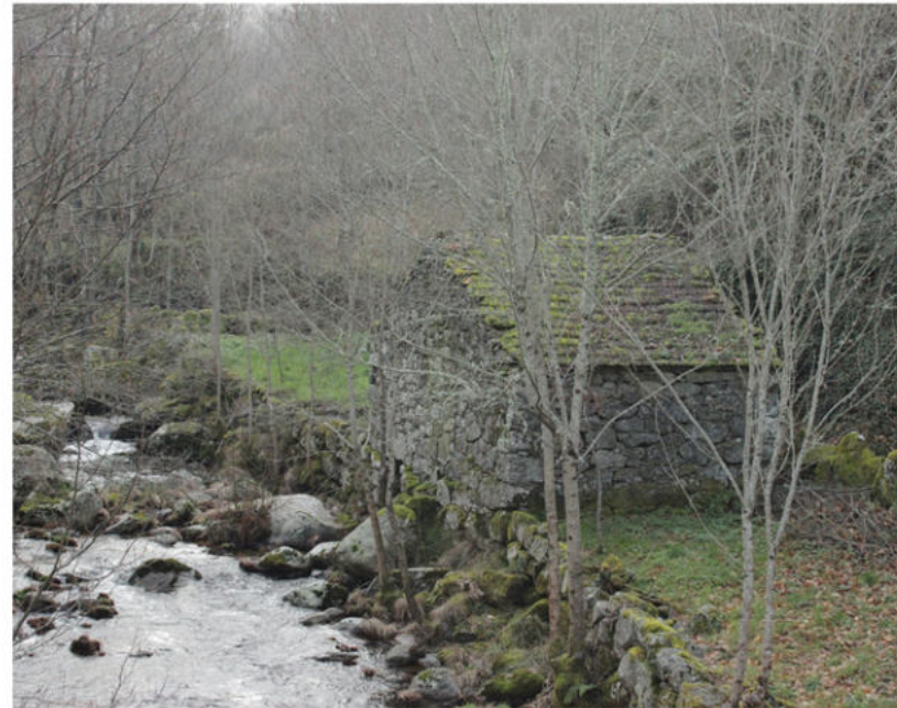
46. Vista do moinho a partir da Ponte do Gardal
