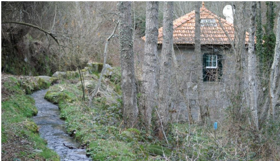
13. Água na levada antes de entrar no cubo do moinho
