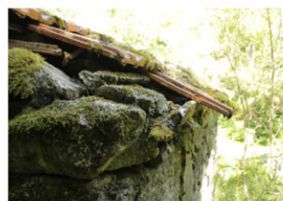
52. Pormenor da cobertura
