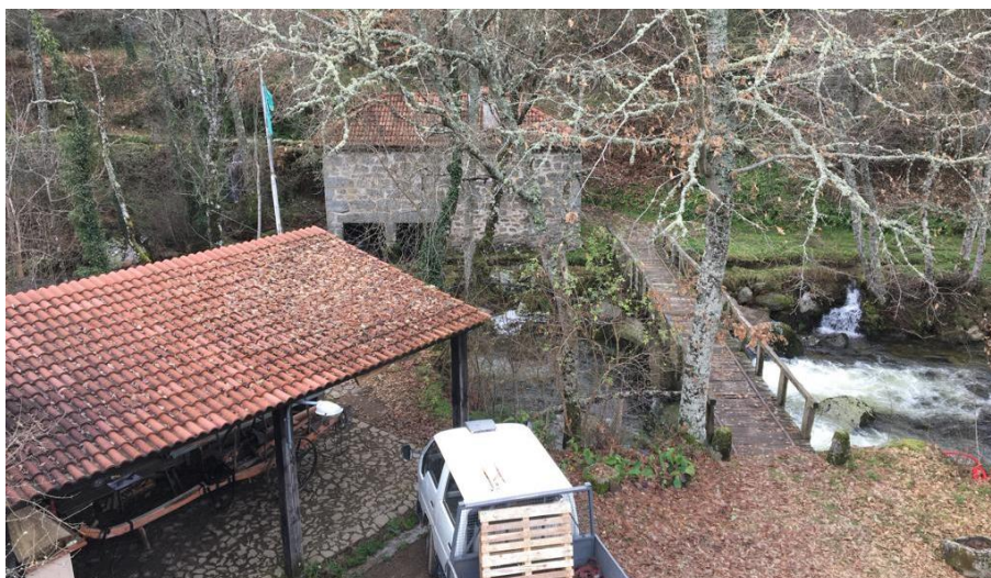
19. Posição do telheiro com a ponte e moinho do Marelo
