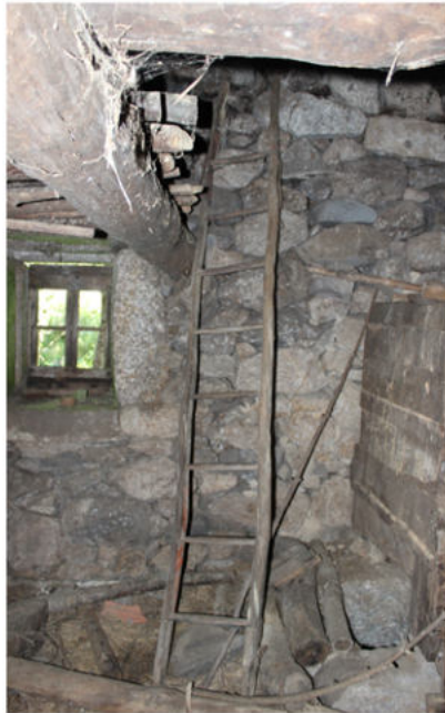
59. Pormenor da janela
