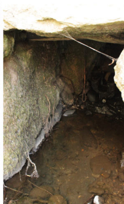
81. Cabouco, já sem o rodízio
