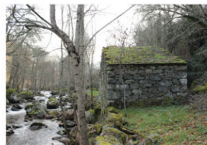
51. Vista do alçado norte
