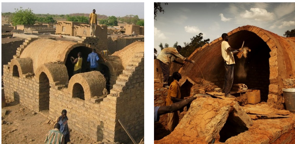
Figura 9 Construção da cobertura em abóbada Núbia.
