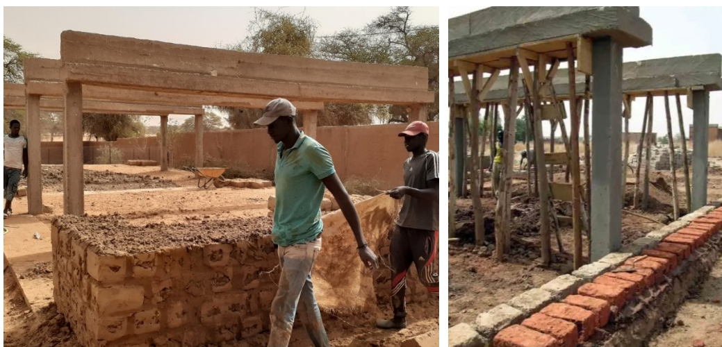
Figura 21 Pórtico de betão armado em construção de abóbadas Núbia.
