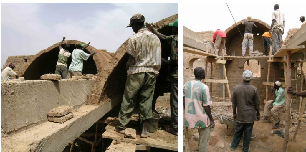
Figura 22 Construção de cobertura em abóbada Núbia pousada em vigas de betão.
