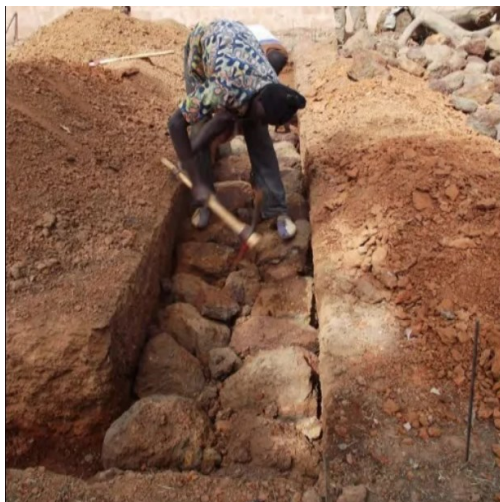
Figura 16 Fundações em pedra selvagem.
