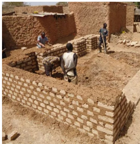
Figura 17 Paredes em blocos de banco.
