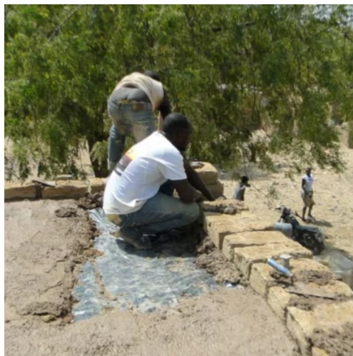
Figura 20 Construção de beiral com sistema de evacuação das águas.
