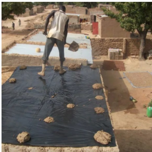
Figura 19 Instalação de uma manta impermeabilizante.
