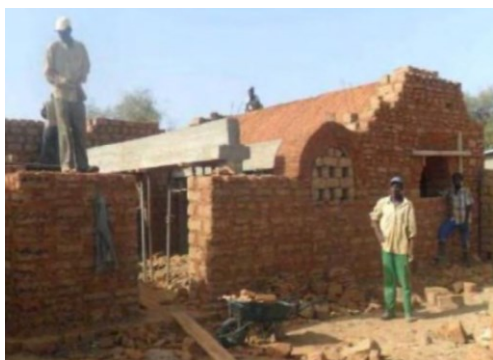
Figura 30 Vista em betão armado em vista no processo de construção da escola de Kodith.
