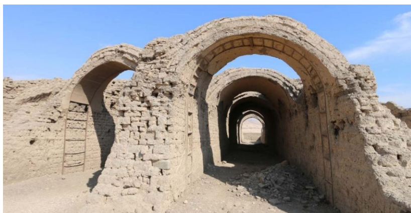
Figura 6 Sôtões construídos em abóbada Núbia. 1300 a.C. Templo de Ramesseum, Egito.
