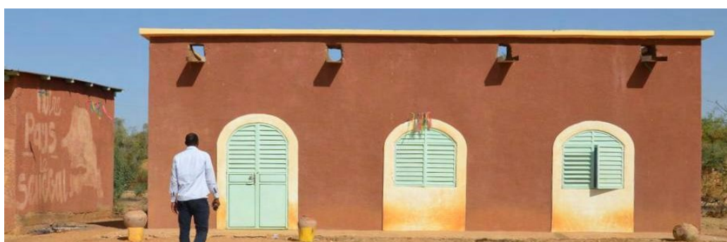
Figura 29 Vista externa da escola de Kodith.
