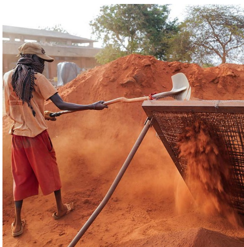
Figura 7 Peneirando o solo.
