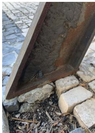
Figura 336: À esquerda, pormenor da prensão do banco ao chão, neste caso zona verde, com possível sapata de cimento (imagem do autor).
