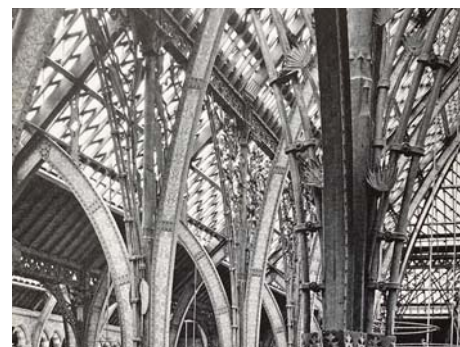
Figura 62: Estrutura arquitetónica em ferro fundido no Museu da Universidade de Oxford (secção de imagem de John Gay em Gay, 1985).
