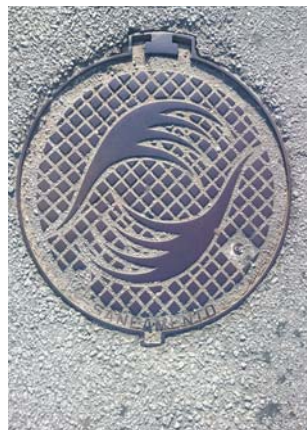
Figura 220: Grelha para escoamento de águas na rua da Paz, Porto (imagem do autor).
