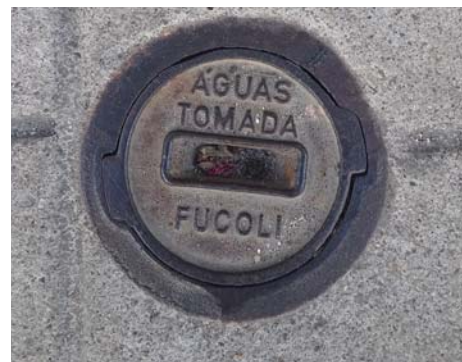
Figura 88: Marcação da Fundição Fucoli numa tampa de águas na via pública, Porto (imagem do autor).
