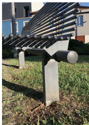
Figura 345: À esquerda, vista de peça de estrutura a dar apoio ao assento e costas. Pormenor da figura 286 pertence a este banco (imagem do autor).
