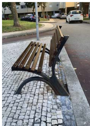
Figura 339: À esquerda, detalhe de como a peça em ferro dá apoio ao assento e serve como pausa braços (imagem do autor).
