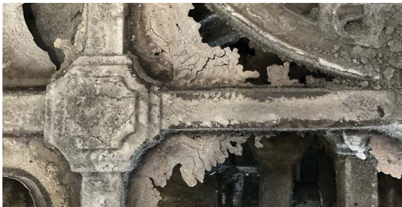
Figura 244: Pormenor da textura da superfície da peça e a zona que tem metal que é necessário remover foi o local onde os moldes de areia encostaram e ficou essa "linha de separação" (imagem do autor).
