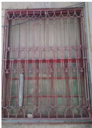
Figura 127: Gradeamento em ferro forjado com detalhes em ferro fundido, rua Miguel Bombarda, Porto (imagem do autor). Figura 128: Gradeamento em rua de Cedofeita, Porto (imagem do autor). Figura 129: Gradeamento em rua de Cedofeita, Porto (imagem do autor).
