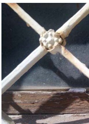
Figura 133: Gradeamento em rua 12, Espinho (imagem do autor). Figura 134: Gradeamento em avenida 8, Espinho (imagem do autor). Figura 135: Gradeamento em rua 14, Espinho (imagem do autor).
