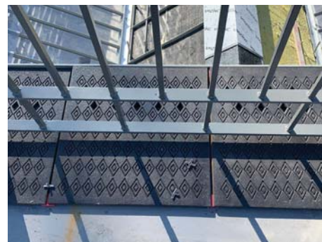
Figura 285: Colocação dos mosaico em fundição de ferro no mercado do Bulhão (imagem de Luís Mendonça).
