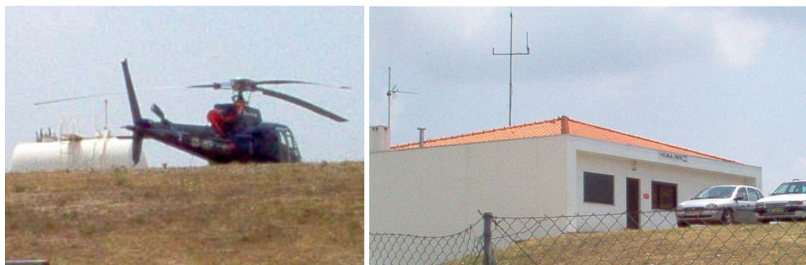
Figura n.º 48 - Helipista e edifício de apoio logístico (Zona Industrial do Socorro, freguesia de Fafe, em Junho de 2006)
