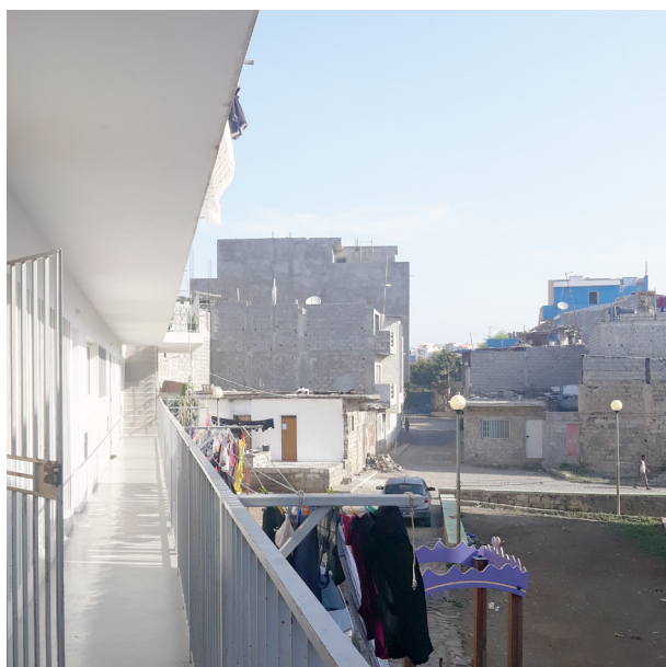
fig. 2 - Contraste entre as duas realidades: habitação autoproduzida e conjunto Casa Para Todos. Bairro Tira-Chapéu. [Fonte: Autora, 2021]
