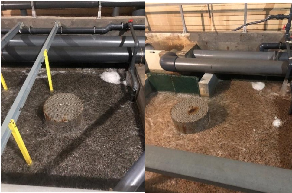
Figura 28 - Biofiltro
