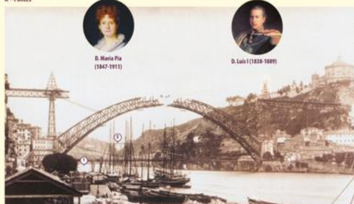
A construção da ponte de D. Luís I na Porto. Fotografia de 1885 mostrando o estado das obras a partir do cais da Ribeira, no Porto. O projeto desta ponte rodoviária deve-se ao eng. Teófilo Seyrig, discípulo e colaborador de Gustave Eiffel. A ponte de D. Luís, que substituiu a ponte péssima ainda visível na fotografia (*), foi executada por uma firma construtora belga e custou 3 mil toneladas de ferro. Inaugurada com toda a pompa no dia 11 de outubro de 1885, nela se pagou portagem até 1920. Assinale-se que, em 1872, as duas margens do Douro haviam ficado unidas pelo comboio, com a inauguração da ponte ferroviária D. Maria Pia (*), nome da rainha e esposa de D. Luís I.
