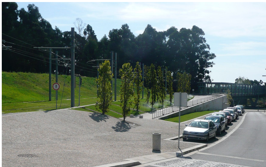
Fig. 3 – Maia. Estação do Parque (Arq. João Álvaro Rocha). Fonte: elaborada pelo autor
