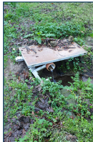
Fig. 47 - Intervenção sobre a linha de água
