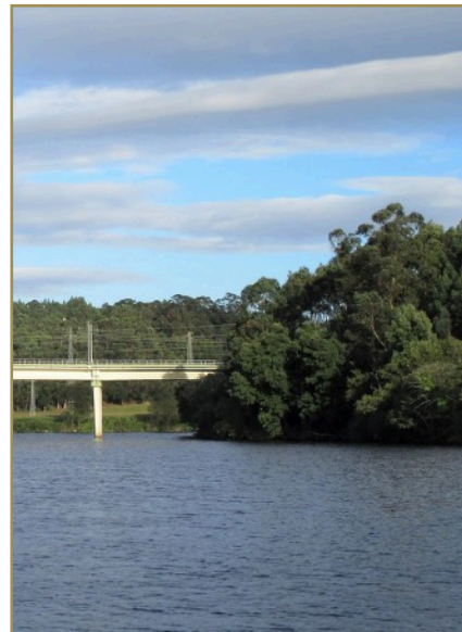
Fig. 22 - Vista para Rio Ave e a ponte do Metro
